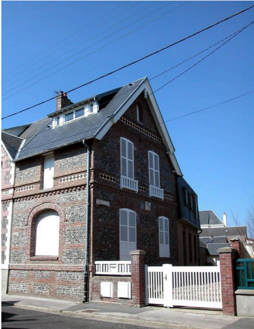
Maison dite La Cayolaise, avec appareil mixte de brique et de silex, 11 rue du Général-Leclerc (1988 BE 12).
