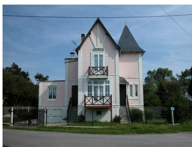
Brighton, Doux Abri (1988 AD 19), gros-oeuvre recouvert d'un enduit d'imitation. Phot. Elisabeth Justome IVR22_20048001583NUCA
