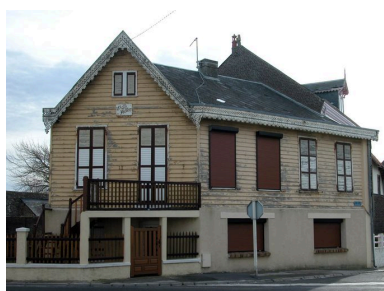
Maison dite Yelka, avec essentage de planches, 48 rue du Général-Leclerc (1988 BE 28). Phot. Elisabeth Justome IVR22_20058002619NUCA
