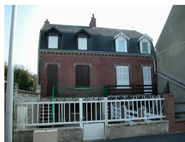
Type de la maison à logements accolés et superposés, 1 et 3 impasse Adolphe Roux (1988 AZ 120, 121). Phot. Elisabeth Justome IVR22_20058003649NUCA
