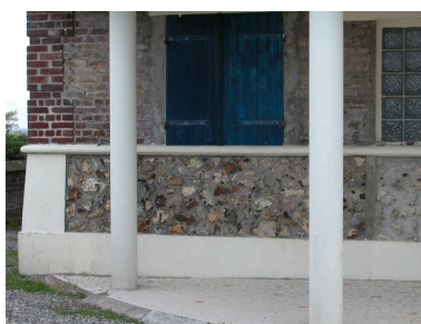
La base du mur de la villa Le Phare, avec gros rognons de silex, 110 rue du Général-Leclerc (1988 AB 36). Phot. Elisabeth Justome IVR22_20058002644NUCA
