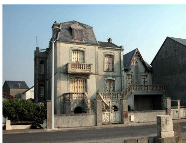
Rez-de-chaussée surélevé, 35 rue du Maréchal-Joffre (1988 AZ 53). Phot. Elisabeth Justome IVR22_20058003093NUCA
