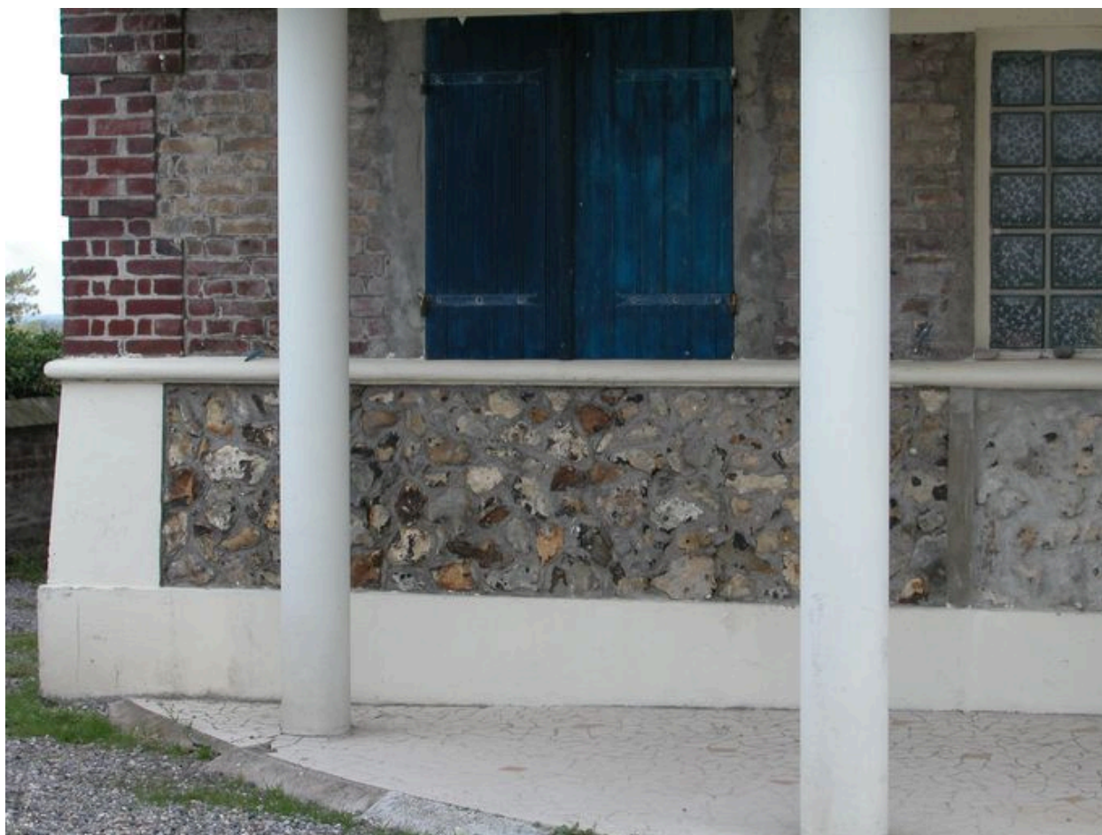
La base du mur de la villa Le Phare, avec gros rognons de silex, 110 rue du Général-Leclerc (1988 AB 36).
