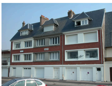
Maison à logements accolés, 3e quart 20e siècle (1988 BE 302, 315, 316). Phot. Elisabeth Justome IVR22_20058003151NUCA
