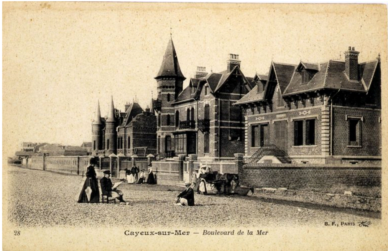
Villas au sud de la digue, détruites, carte postale, 1er quart 20e siècle (coll. part.).
