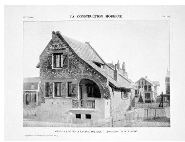
Villa le Pavé, détruite, construite vers 1910 avec un parement de galets en façade (AD Somme ; 1 J 3584/11). Phot. Monnehay-Vulliet Marie-Laure IVR22_20038000339XB
