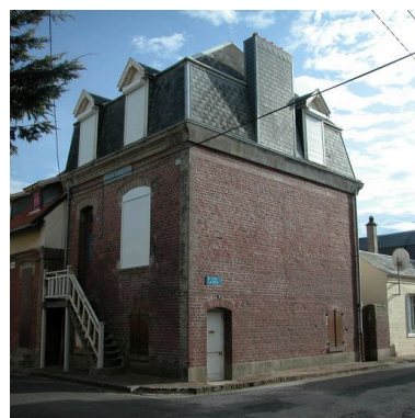
Soubassement habitable, Villa Charles, 15 rue Adolphe Roux (1988 AZ 90). Phot. Elisabeth Justome IVR22_20058002604NUCA
