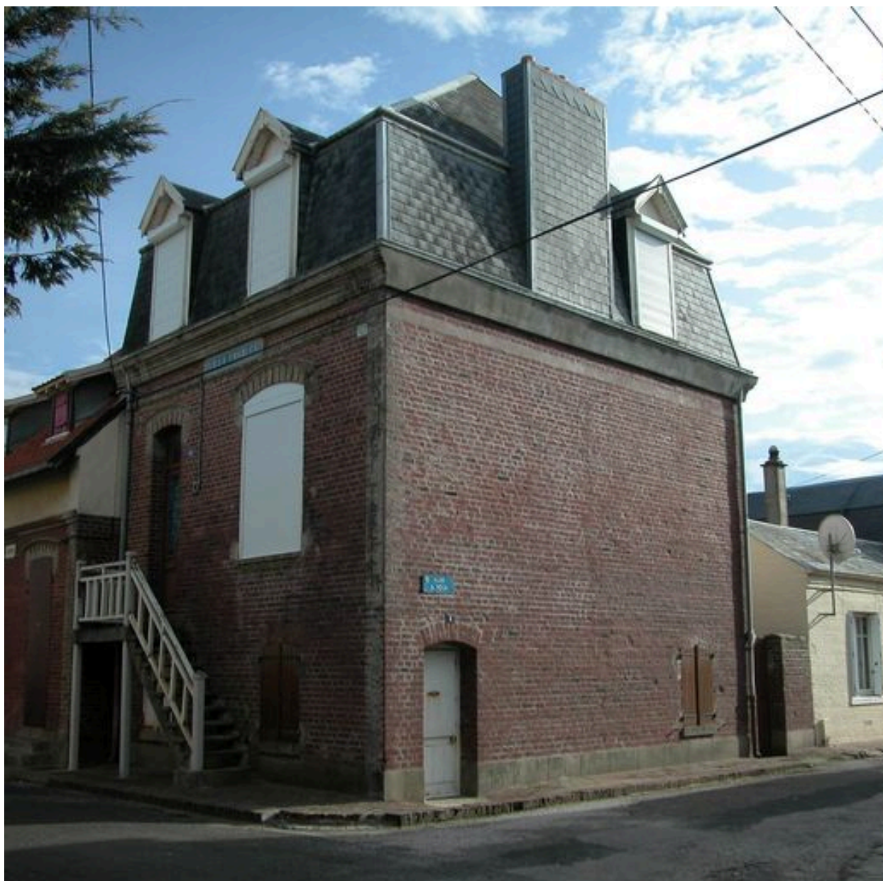
Soubassement habitable, Villa Charles, 15 rue Adolphe Roux (1988 AZ 90).
