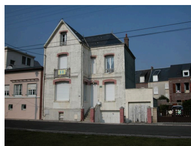
Aménagement tardif d'un garage en soubassement. Phot. Elisabeth Justome IVR22_20058003096NUCA
