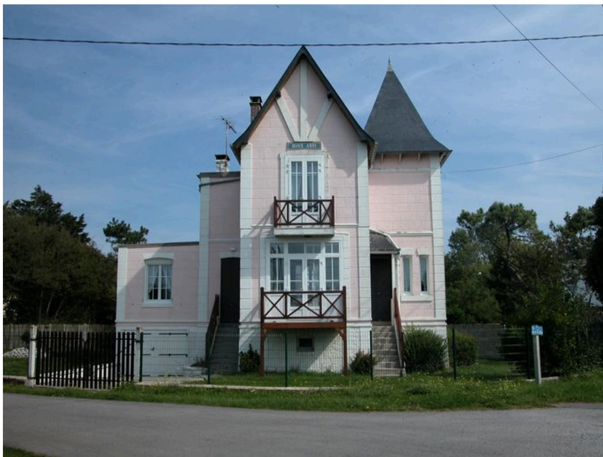
Brighton, Doux Abri (1988 AD 19), gros-oeuvre recouvert d'un enduit d'imitation.
