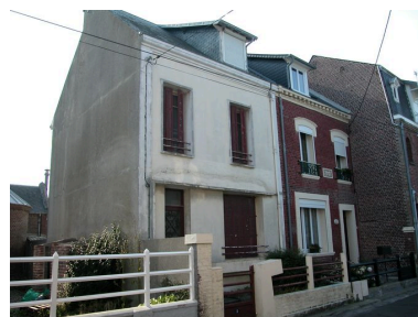
Traitement différencié des façades, 1 et 3 rue des Hironnelles (1988 BE 354, 355). Phot. Elisabeth Justome IVR22_20058003094NUCA
