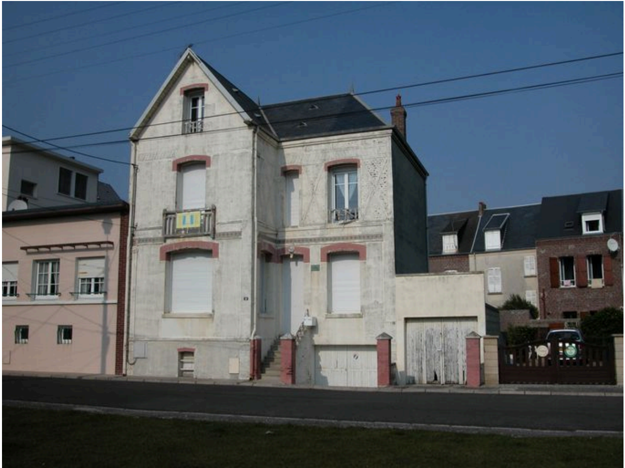
Aménagement tardif d'un garage en soubassement.
