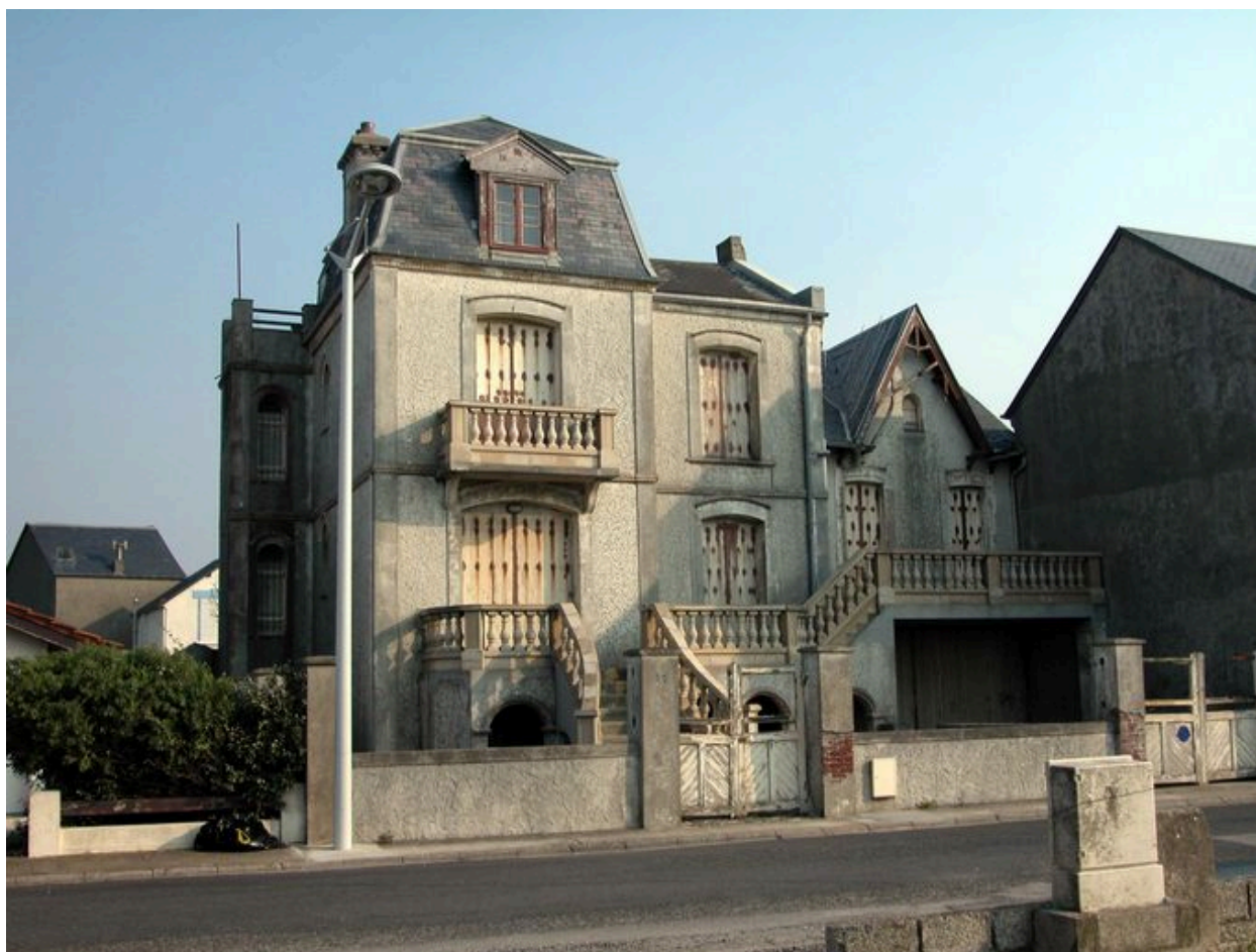
Rez-de-chaussée surélevé, 35 rue du Maréchal-Joffre (1988 AZ 53).
