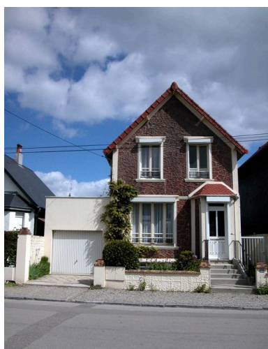
Enduit imitant des moellons de pierre, avenue Carnot (1988 BB 77). Phot. Elisabeth Justome IVR22_20058002828NUCA
