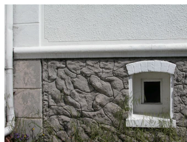
Enduit imitant des moellons de pierre, base du mur des maisons Les Mouettes et Les Tilleuls, avenue Carnot (1988 BB 34, 35). Phot. Elisabeth Justome IVR22_20058002848NUCA
