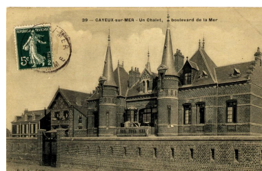
'Chalet' de M. Black, élévation antérieure, détruite, carte postale, 1er quart 20e siècle (coll. part.). Phot. Monnehay-Vulliet Marie-Laure IVR22_20058000472XAB
