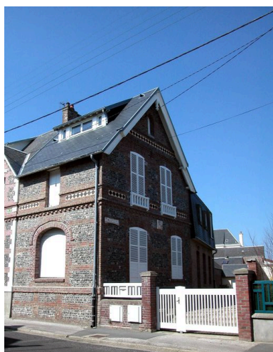
Maison dite La Cayolaise, avec appareil mixte de brique et de silex, 11 rue du Général- Leclerc (1988 BE 12). Phot. Elisabeth Justome IVR22_20058002697NUCA
