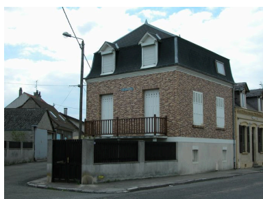
Maison dénaturée, dite Le Sourire, avenue Paul-Doumer. Phot. Elisabeth Justome IVR22_20058003668NUCA
