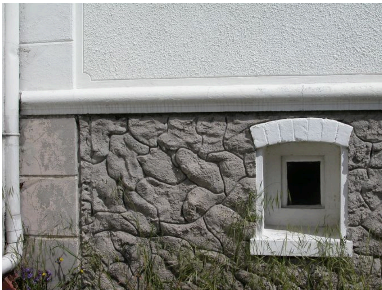
Enduit imitant des moellons de pierre, base du mur des maisons Les Mouettes et Les Tilleuls, avenue Carnot (1988 BB 34, 35).
