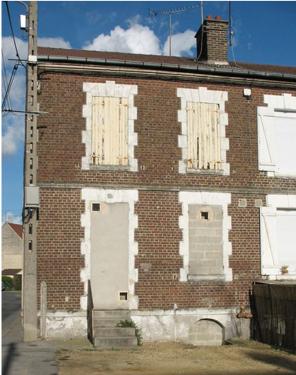
Elévation d'un logement construit sur sous-sol, rez-de-chaussée surélevé, un étage carré et comble.
