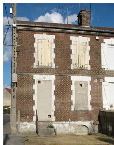
Elévation d'un logement construit sur sous-sol, rez-de-chaussée surélevé, un étage carré et comble. Phot. Clarisse Lorieux IVR22_20076005557NUCA
