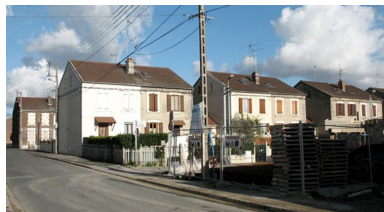
Vue générale des deux bandes de maisons constituant la cité ouvrière Louis Blanc Phot. Clarisse Lorieux IVR22_20076005554NUCA
