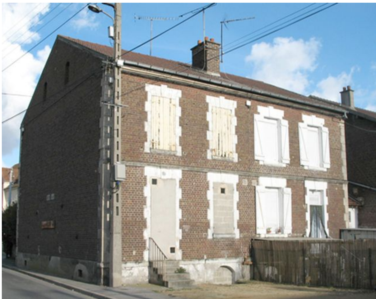
Détail d'une maisons divisée en quatre logements dont deux dos à dos.
