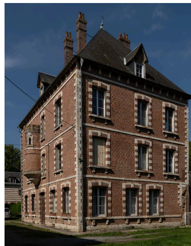
Vue du pavillon sud depuis l'est. Phot. Marc Kérignard IVR32_20216000984NUCA
