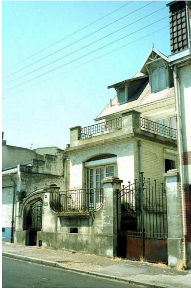
Vue générale en 1996. Phot. Richard Klein IVR31_19966201508ZE
