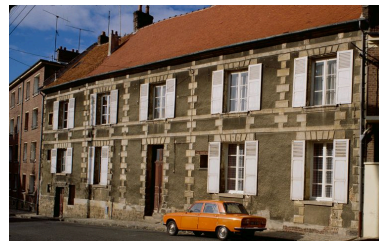
Élévation antérieure. Phot. Alain Nafilyan IVR22_19856001453ZA
