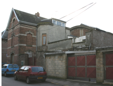
Le site vu depuis la rue du Jeu de Battoir. Phot. Frédéric Pillet IVR22_20060205000NUCA
