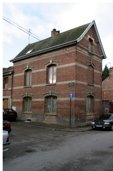
Les bureaux surmontés d'un logement, à l'angle de la rue Jacques- Arpin et de la rue du Jeu de Battoir. Phot. Frédéric Pillet IVR22_20060205001NUCA
