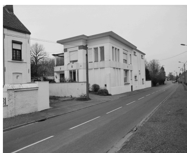
La façade sobre sur rue de la maison Art-Déco. Phot. Philippe Dapvril IVR31_20045900054X
