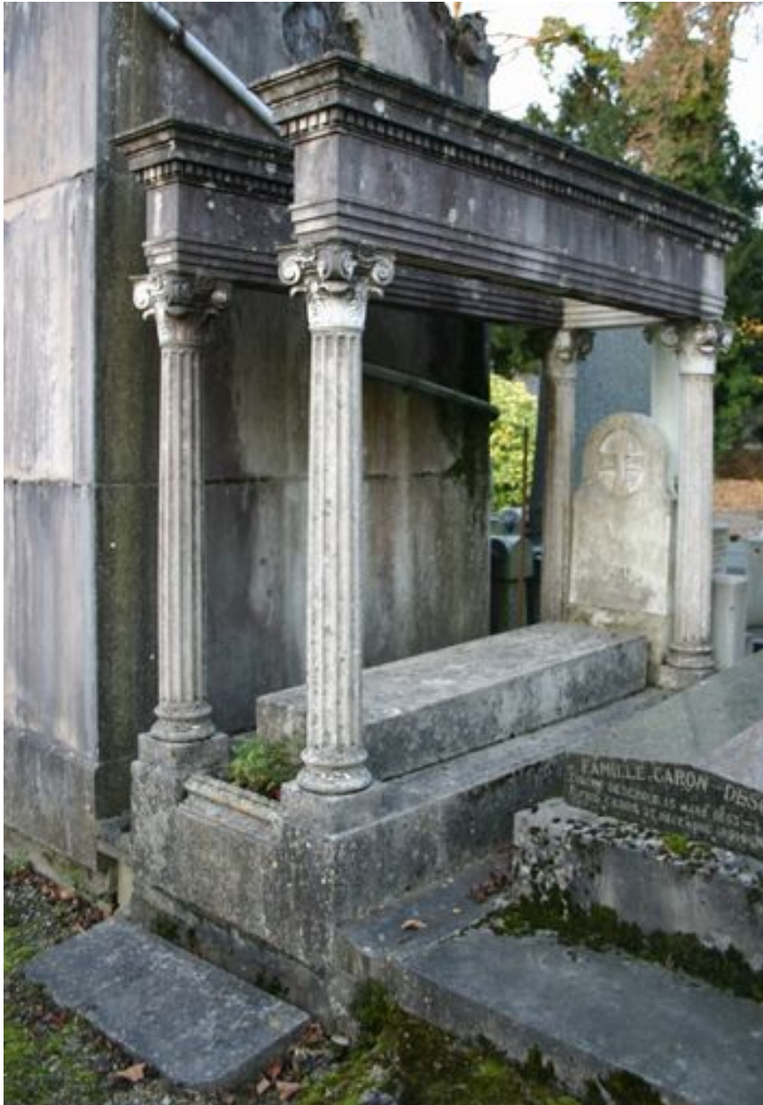
Vue générale, depuis le côté.
