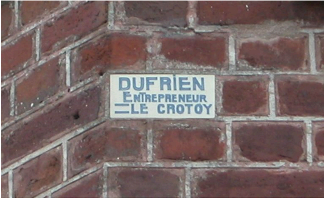
Détail du carreau de céramique portant signature du maître d'oeuvre, Dufrien entrepreneur au Crotoy.
