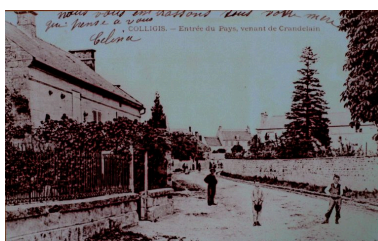
Vue de l'entrée de Colligis depuis Crandelain (coll. part). Phot. Leullier Irwin IVR22_20050200669NUCAB
