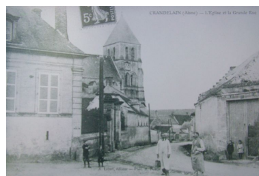
Vue ancienne de l'église et de la grande rue de Crandelain (coll. part). Phot. Inès Guérin IVR22_20030202576NUCAB
