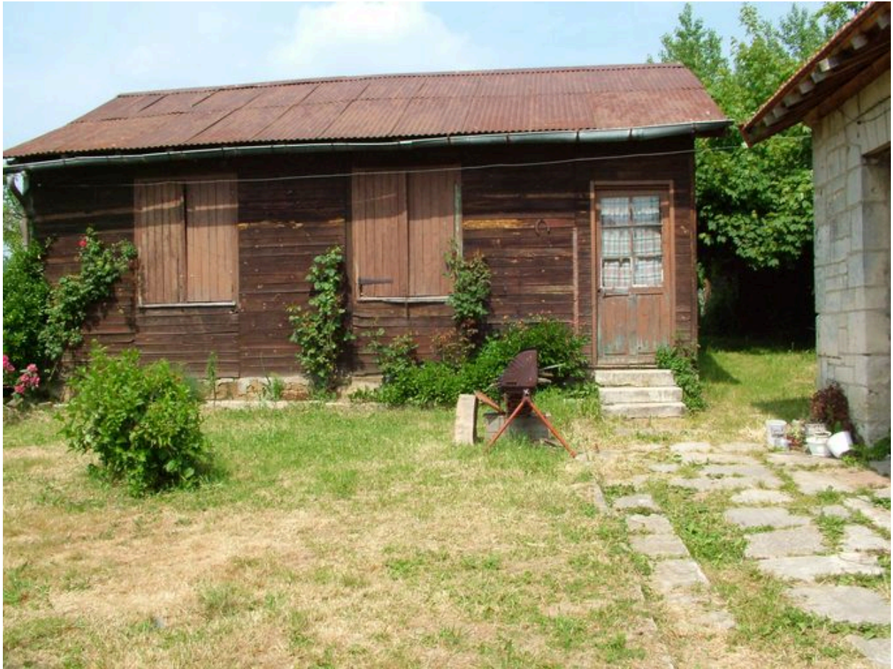
Vue d'une maison provisoire.
