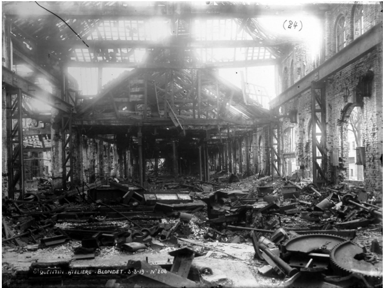
Vue intérieure des ateliers de construction mécanique bordant le boulevard Henri-Martin, 1919 (AD Aisne).
