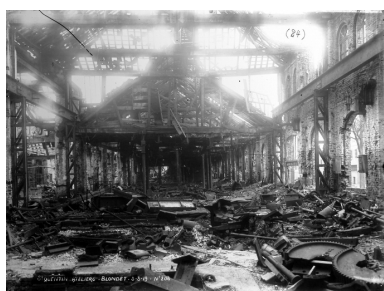
Vue intérieure des ateliers de construction mécanique bordant le boulevard Henri- Martin, 1919 (AD Aisne). Phot. Pillet Frédéric IVR22_20050206041NUCAB
