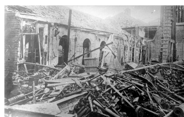
Les ateliers de construction mécanique en 1919 (BM Saint-Quentin). Phot. Pillet Frédéric IVR22_20050206040NUCAB
