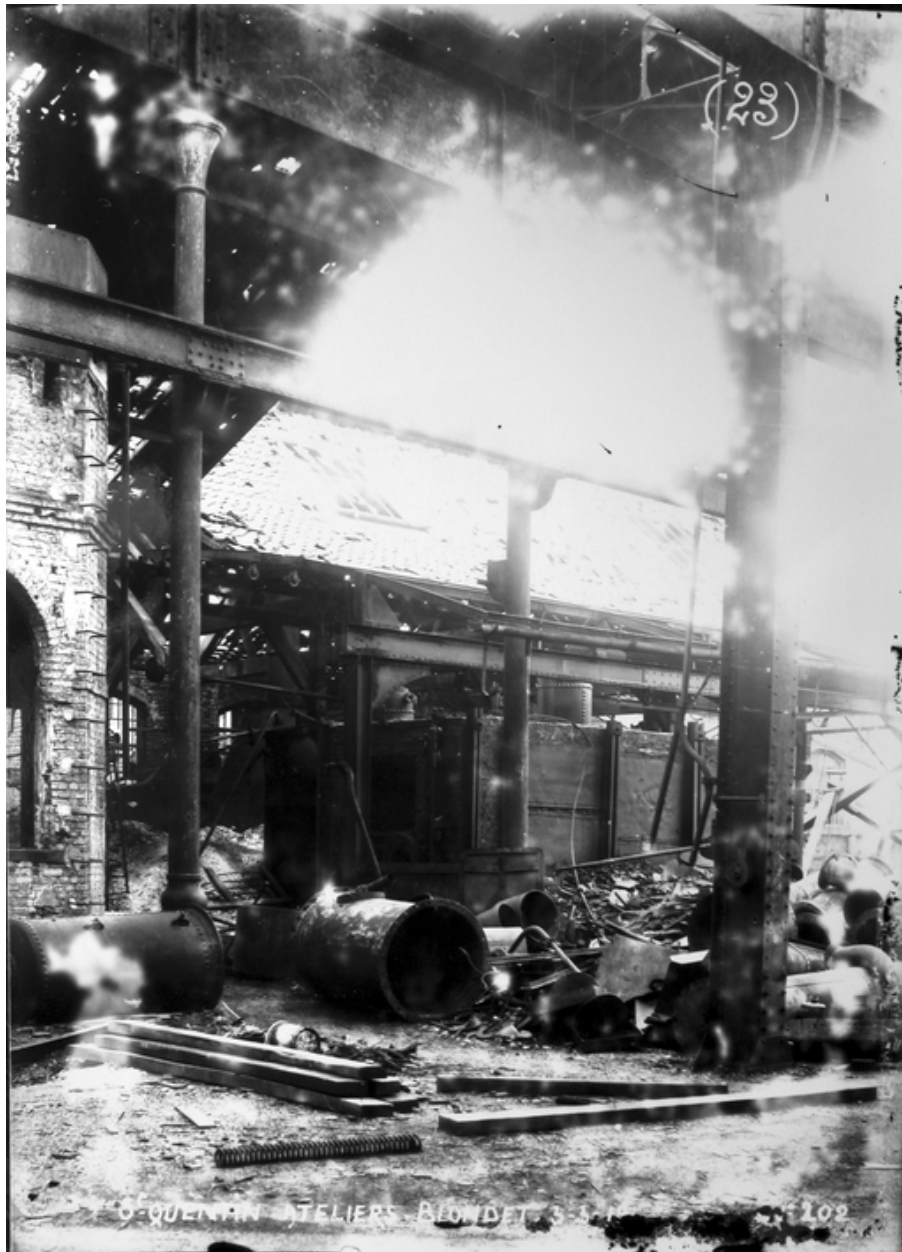
Les ateliers en ruine, 1919 (AD Aisne).
