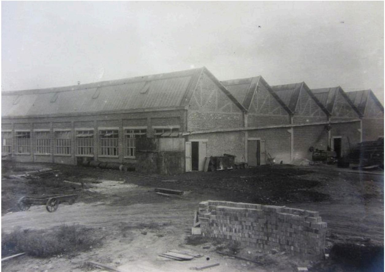
Les ateliers en shed de la tréfilerie, vers 1922 (AD Somme ; 10 R 625).
