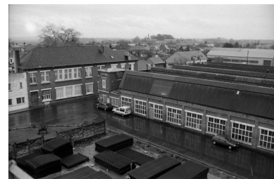
Atelier de fabrication et bureau : flanc nord-est.
