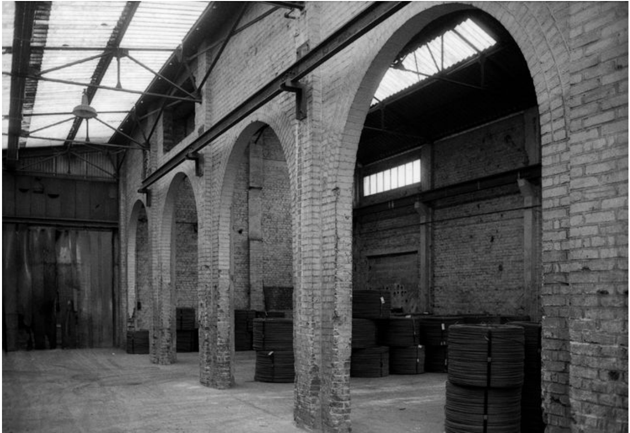
Atelier de fabrication : vue intérieure.
