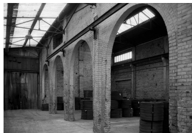
Atelier de fabrication : vue intérieure.
