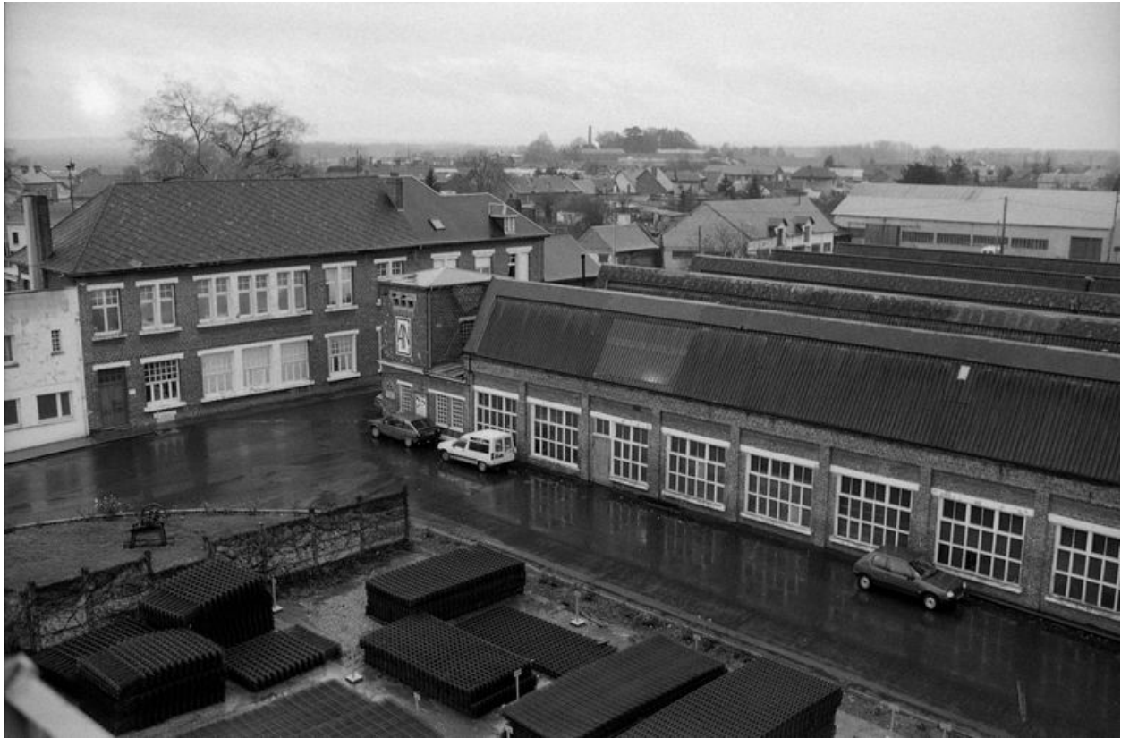
Atelier de fabrication et bureau : flanc nord-est.
