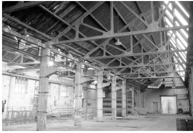
Atelier de fabrication : vue intérieure. Phot. Francis Dubuc IVR22_19908001401Z
