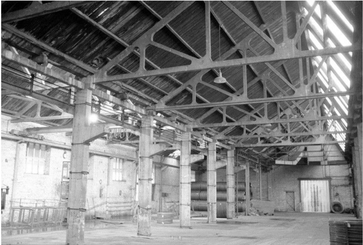
Atelier de fabrication : vue intérieure.
