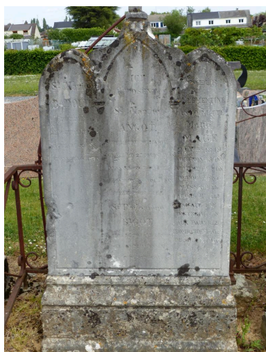
Stèle funéraire située à gauche de la concession. Phot. Isabelle Barbedor IVR32_20228005092NUCA
