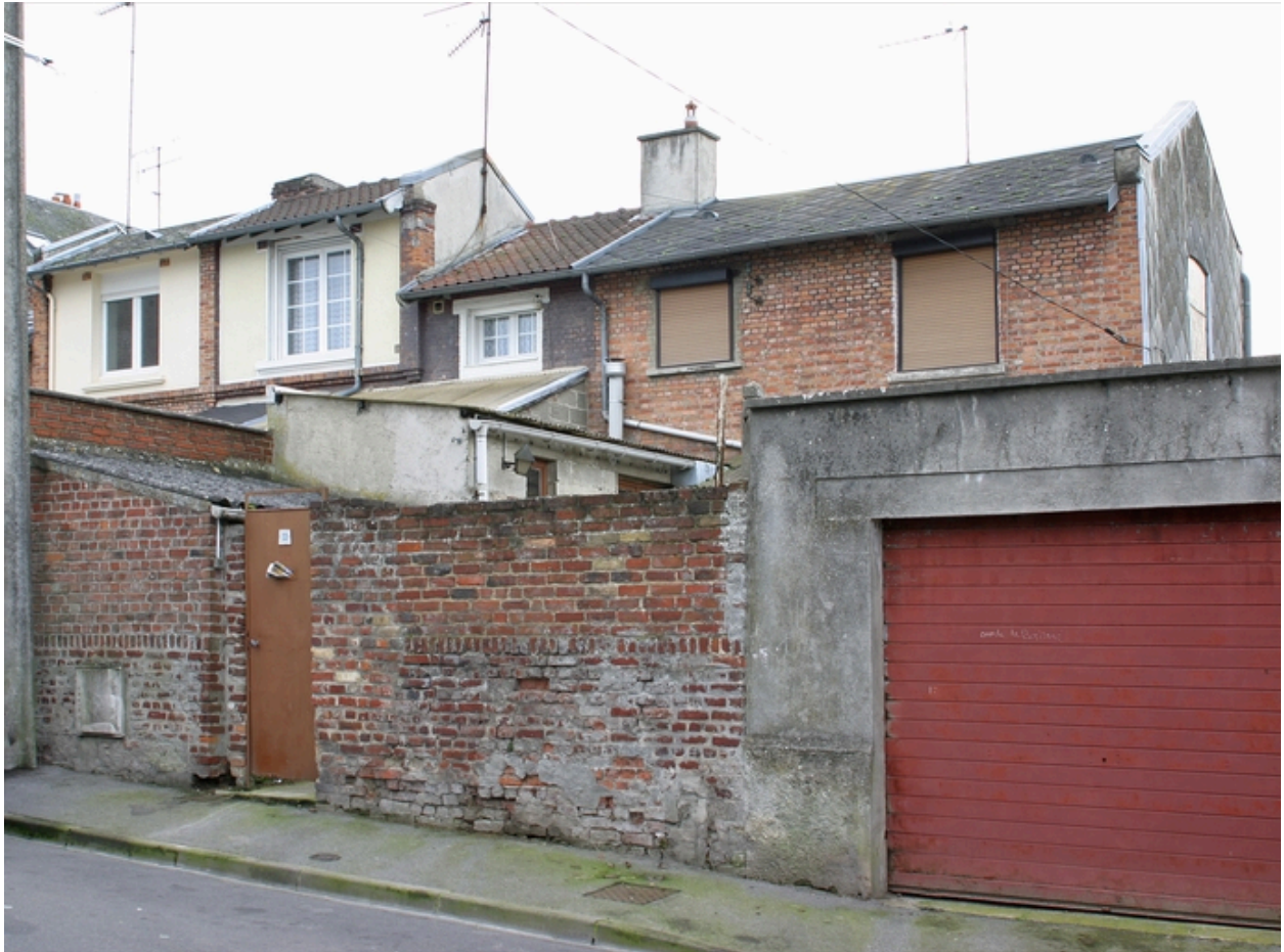
Logements de la rue de Flandre.
