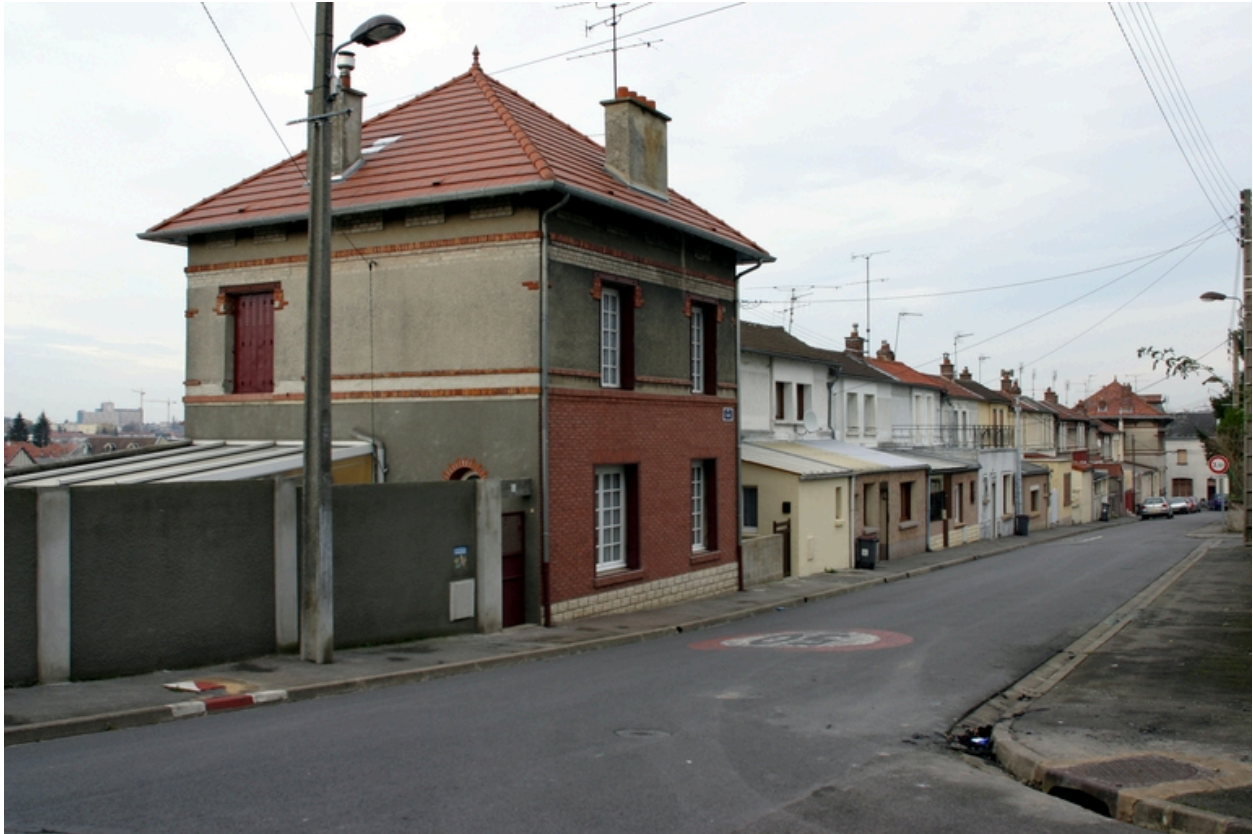
Vue d'ensemble de la cité, rue d'Amiens.
