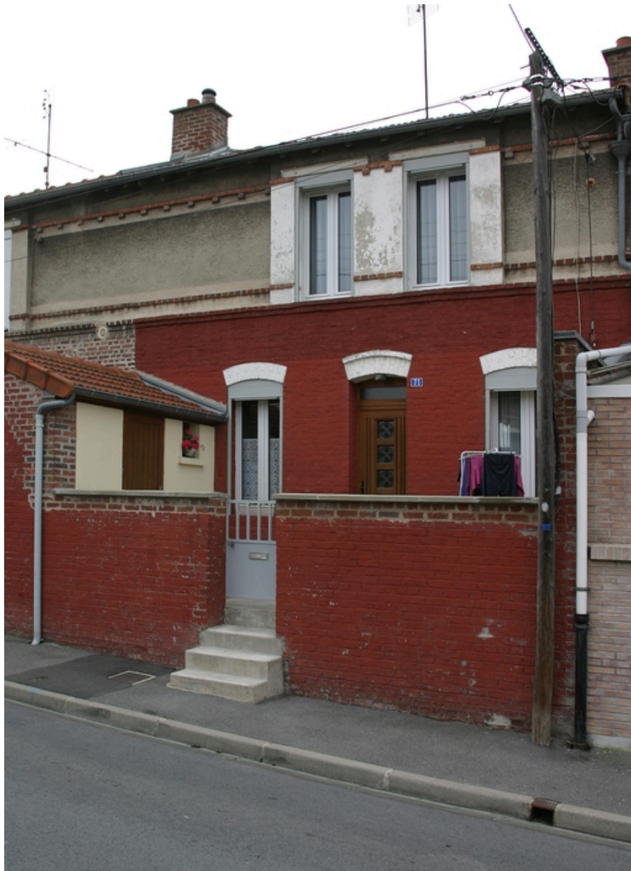
Logement type de la rue d'Amiens.
