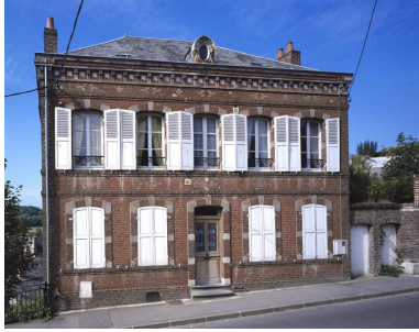
Vue de la façade sur rue. Phot. Thierry Lefébure IVR22_19990202921VA
