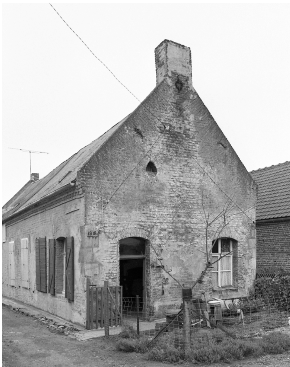
Vue d'ensemble nord-est.
