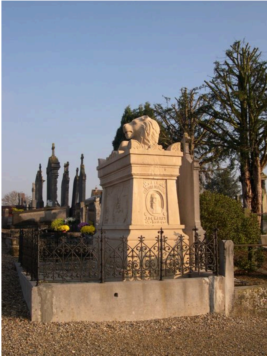
Vue générale, depuis le sud-ouest.
