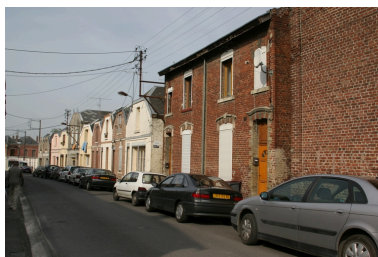
De gauche à droite : la ruelle Sainte-Marguerite, deux logements indépendants, l'entrée de la cour et les six logements en bordure de la rue Denfert-Rochereau. Phot. Frédéric Pillet IVR22_20070205169NUCA
