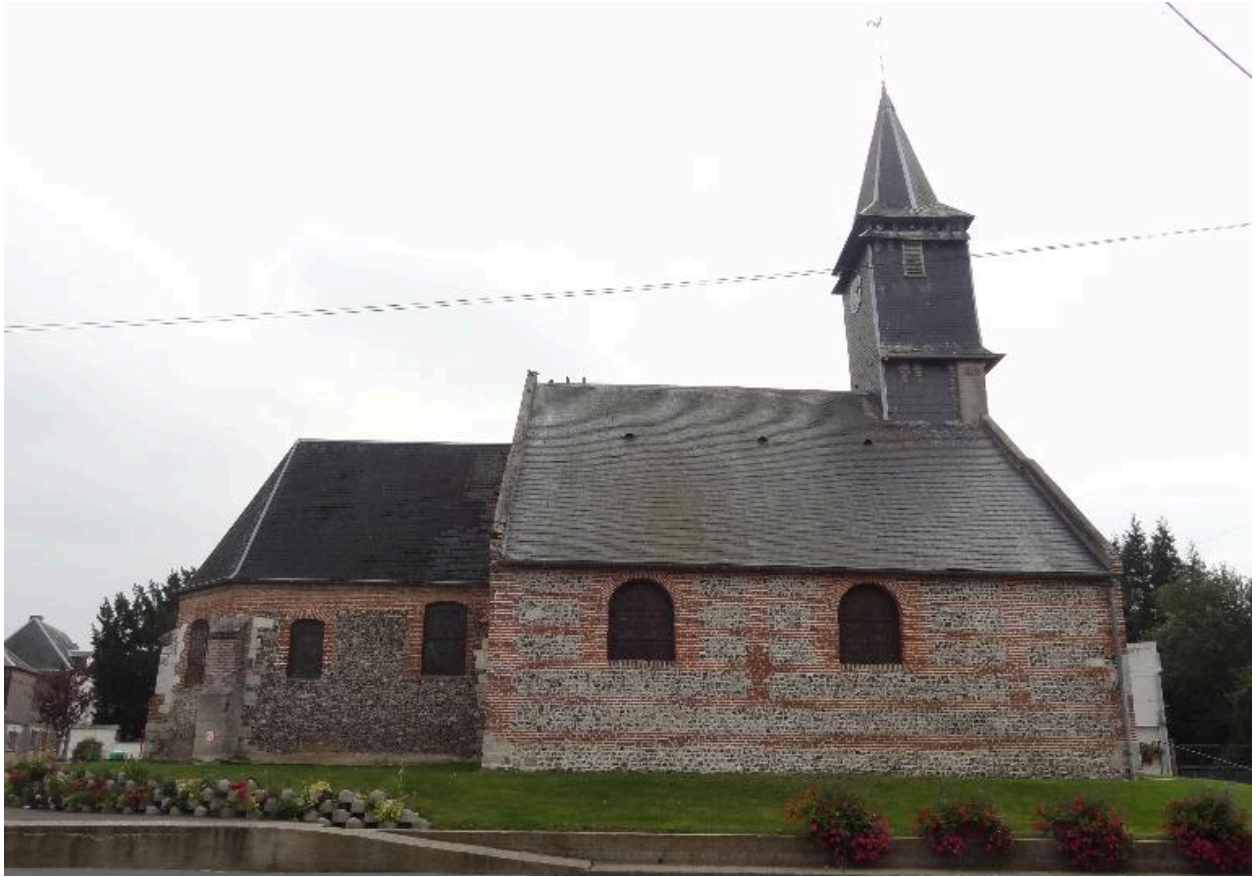
Vue générale depuis la rue Jean-Moulin.
