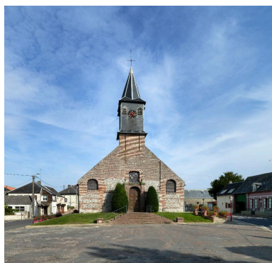
Vue générale depuis la place de l'église. Phot. Thierry Lefébure IVR22_20148000518NUC2A
