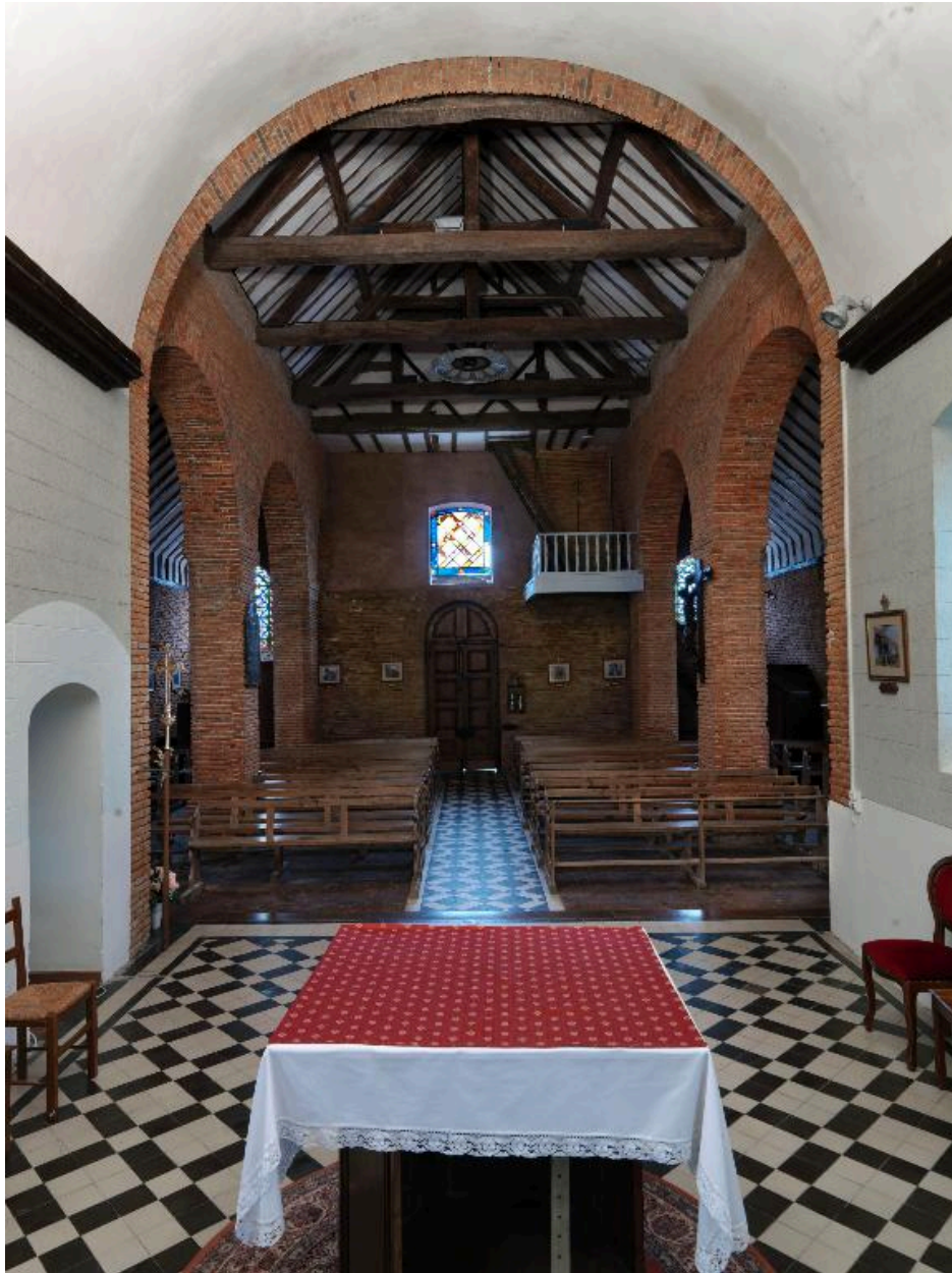
Vue du choeur vers la nef.
