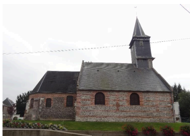
Vue générale depuis la rue Jean-Moulin. Phot. Frédéric-Nicolas Kocourek IVR22_20158005023NUCA
