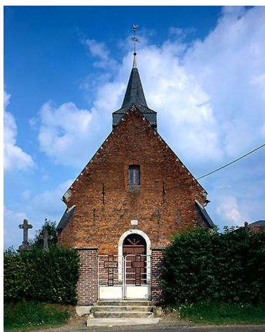
Façade occidentale. Phot. Franck Bürjes IVR22_19990204125VA
