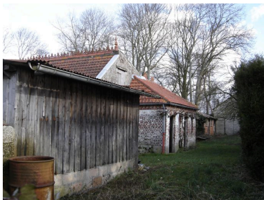
Etables à cochons adossées au pignon sud. Phot. Inès Guérin IVR22_20058005262NUCA
