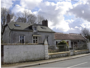
Vue générale. Phot. Inès Guérin IVR22_20058005259NUCA
