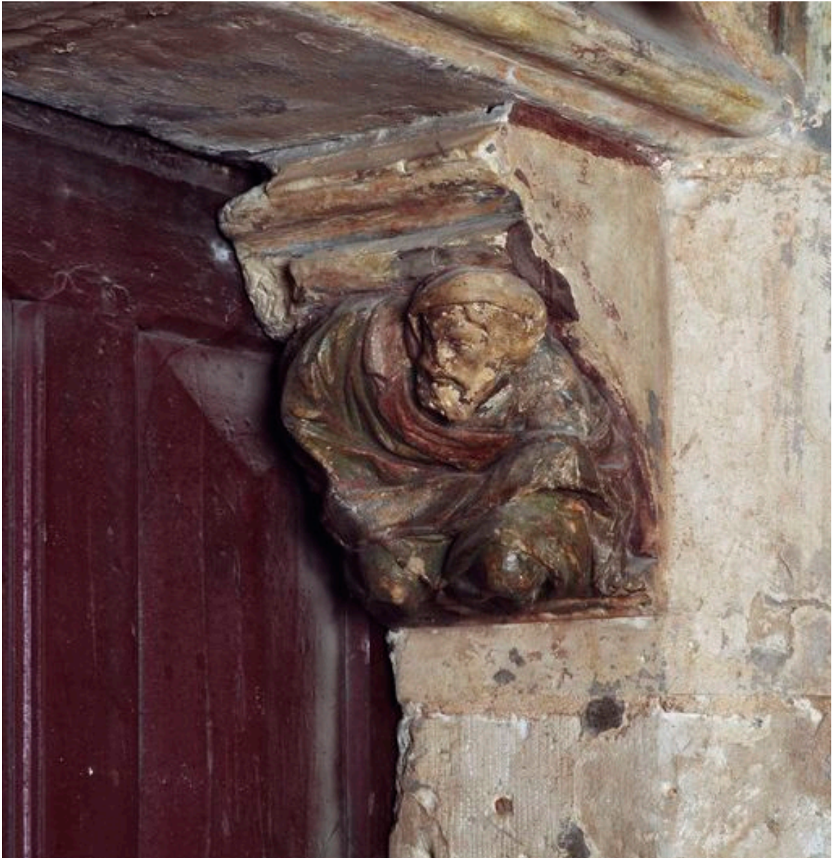
Décor du corbeau droit, après restauration.
