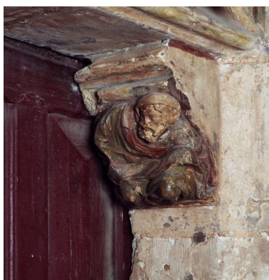
Décor du corbeau droit, après restauration. Phot. Thierry Lefébure IVR22_20090200401XA
