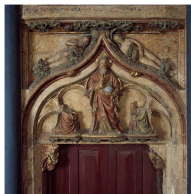
Décor du tympan de la porte, après restauration. Phot. Thierry Lefébure IVR22_20090200399XA
