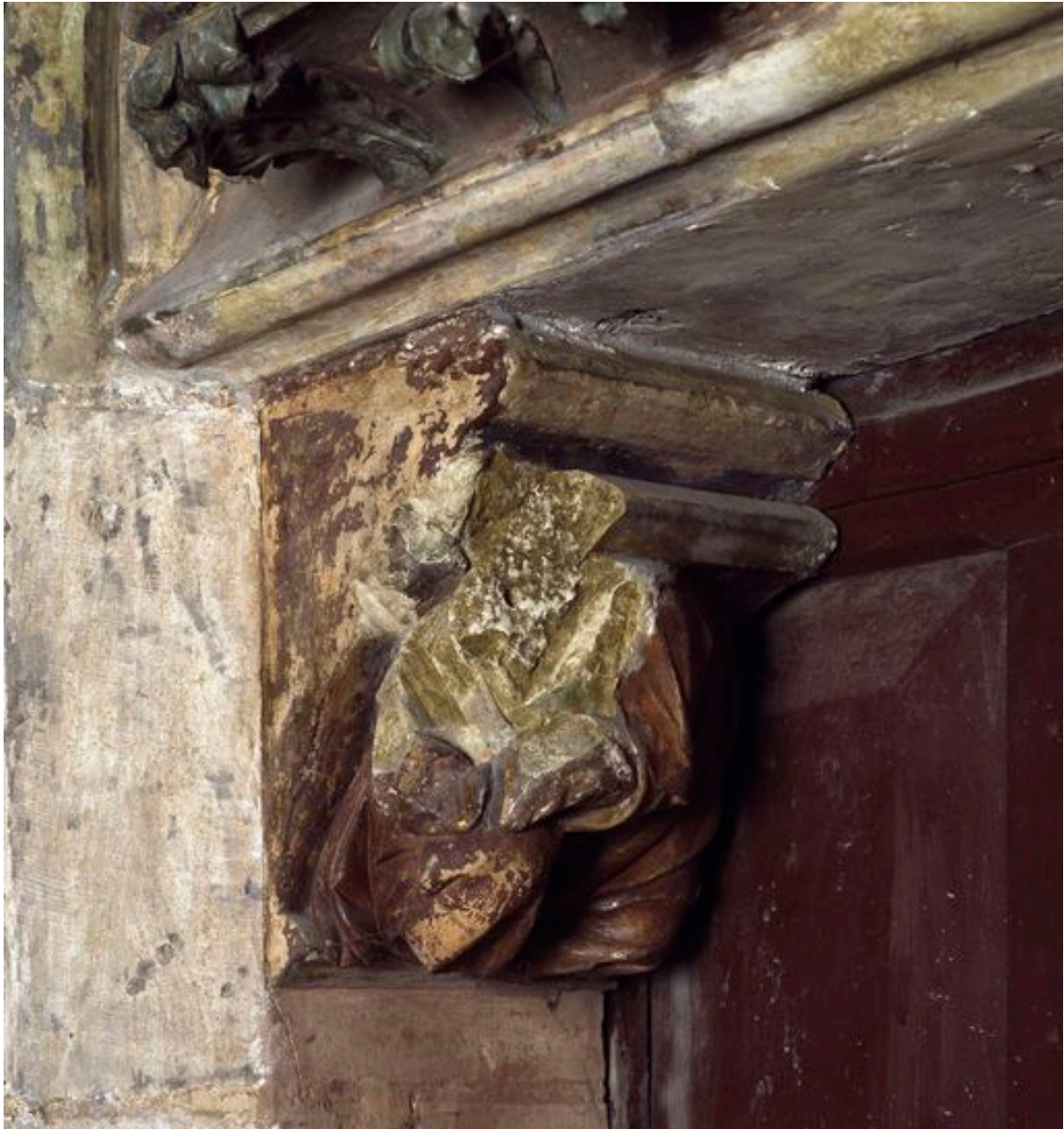
Décor du corbeau gauche, après restauration.
