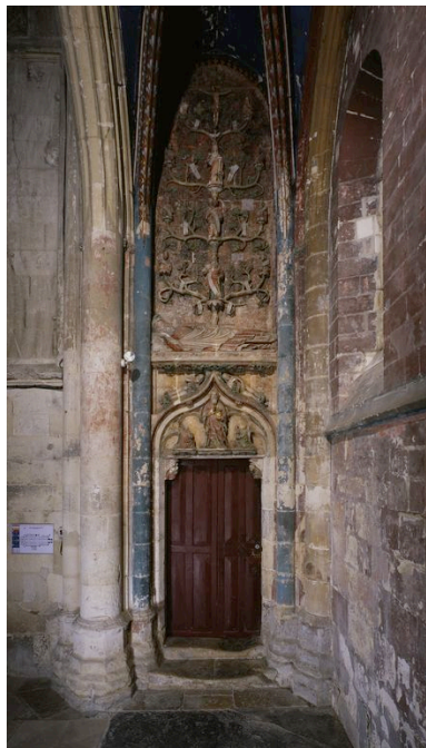
Vue générale, avant restauration. Phot. Thierry Lefébure IVR22_20010202824PA
