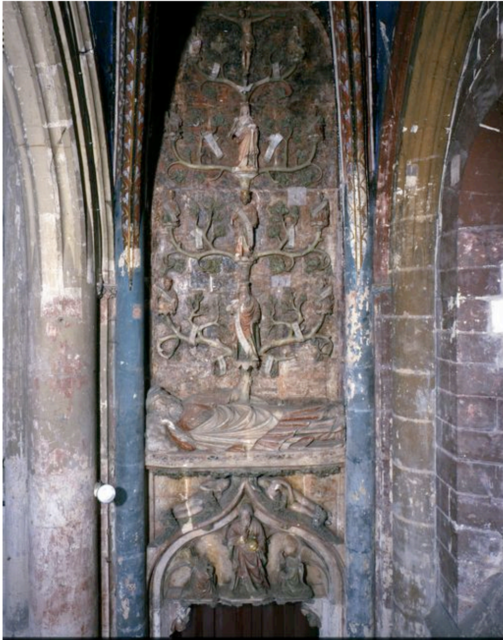
Vue de l'arbre de Jessé, avant restauration.
