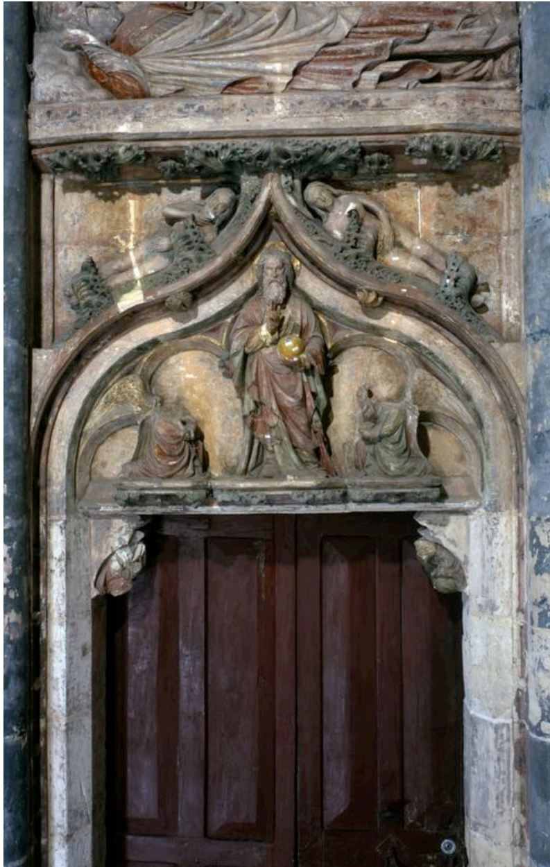
Vue de la partie inférieure du relief (Dieu le Père, Adam et Eve), avant restauration.
