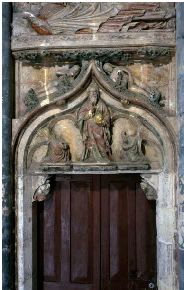
Vue de la partie inférieure du relief (Dieu le Père, Adam et Eve), avant restauration. Phot. Thierry Lefébure IVR22_20010202831XA
