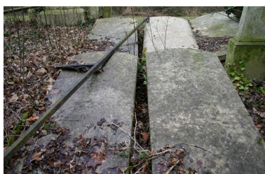
Tombeaux en forme de sarcophage réalisés vers 1845, 1848, 1862 et 1877. Phot. Caroline Vincent IVR22_20098000623NUCA
