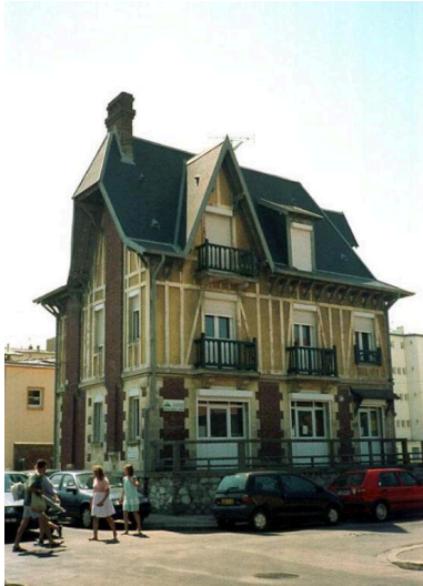
Vue générale. Phot. Richard Klein IVR31_19966201522ZE
