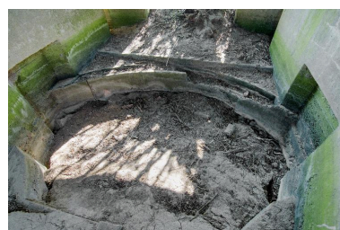
Vue intérieure vers l'entrée de la chambre de tir avant déblaiement. On distingue bien, dans les premiers plans, l'arc de cercle du support de crosse et les dégagements latéraux Phot. Jean-Marc Ramette IVR32_20175901049NUCA
