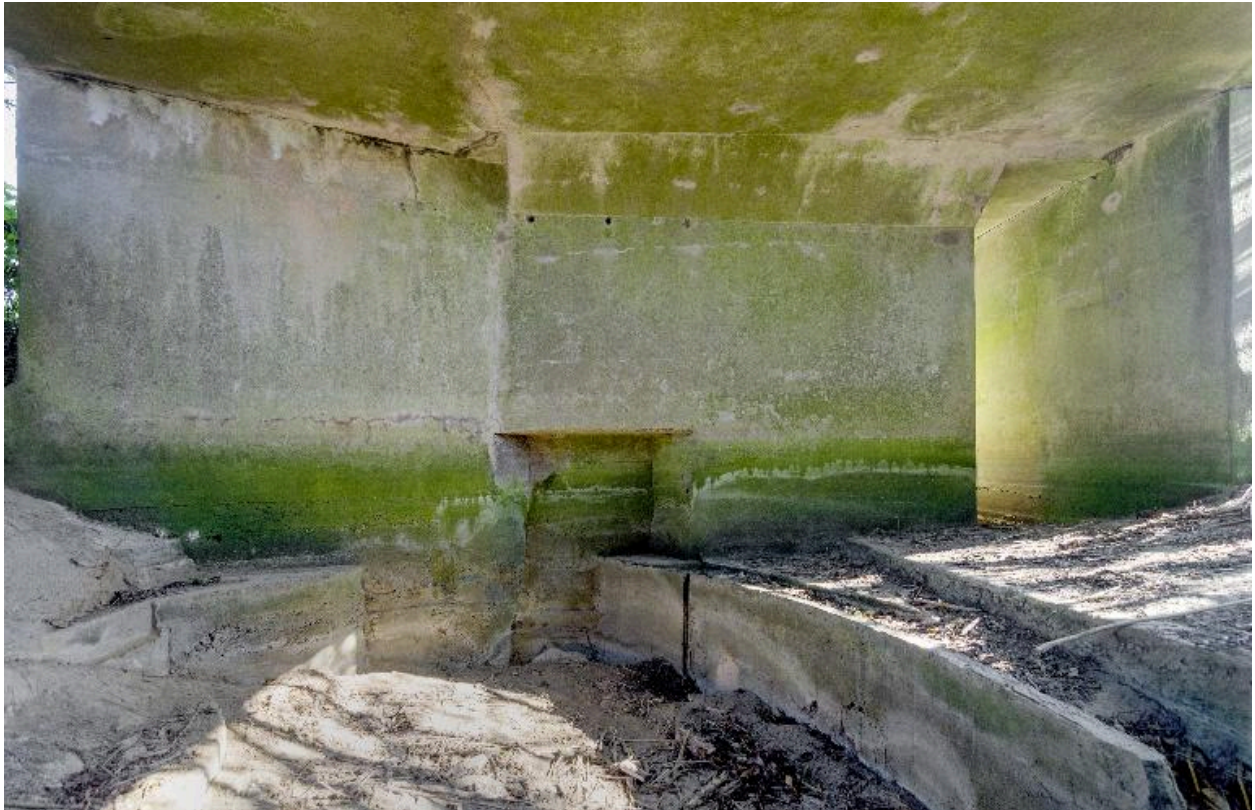
Depuis la cuve à canon de la chambre de tir, vers l'est et avant déblaiement.
