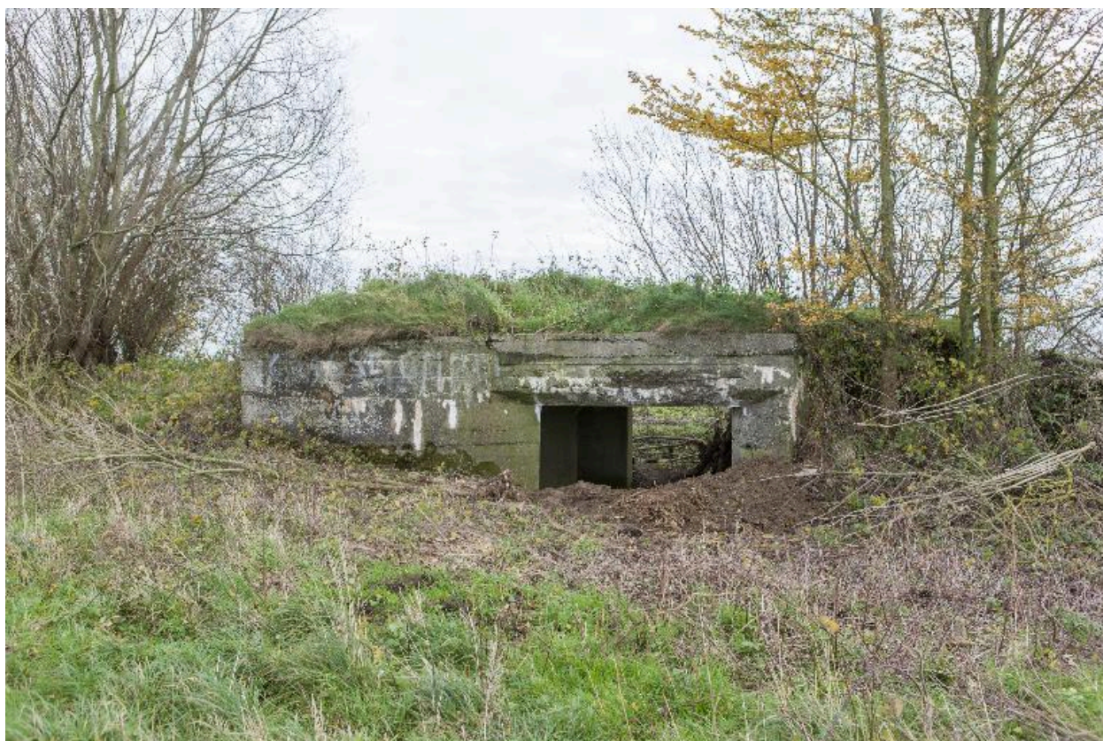
Elévation nord-ouest : sortie de la chambre de tir
