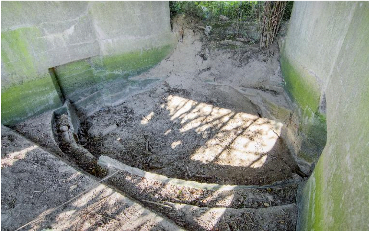
Vue intérieure vers le sortie de la chambre de tir avant déblaiement. Au sol apparait les infrastructures de la plate-forme d'artillerie, notamment le chemin de roulement du support de crosse
