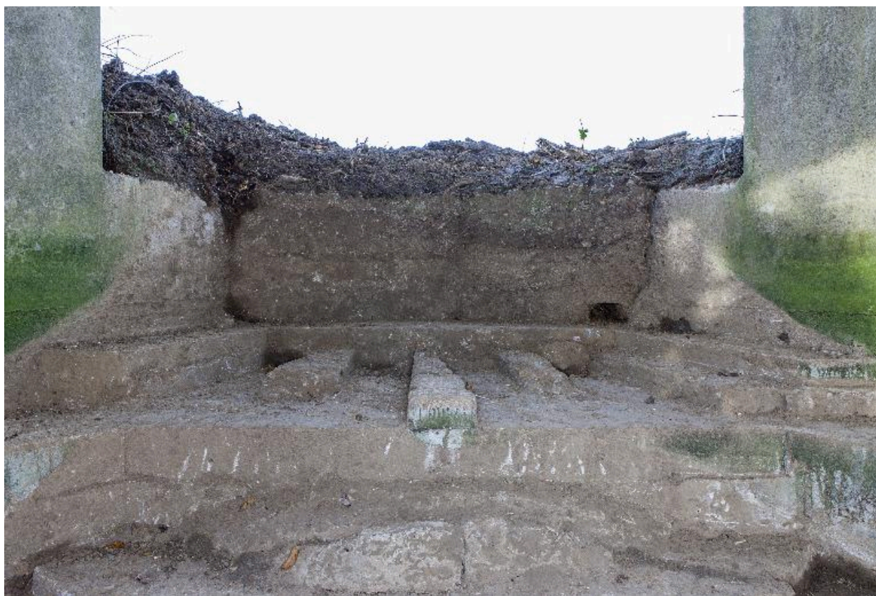
Intérieur de la chambre de tir, vers la sortie, avec, au sol, la plate-forme du canon (détail)
