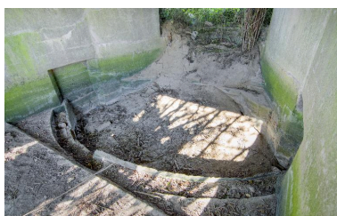
Vue intérieure vers le sortie de la chambre de tir avant déblaiement. Au sol apparaît les infrastructures de la plate-forme d'artillerie, notamment le chemin de roulement du support de crosse Phot. Jean-Marc Ramette IVR32_20175901048NUCA
