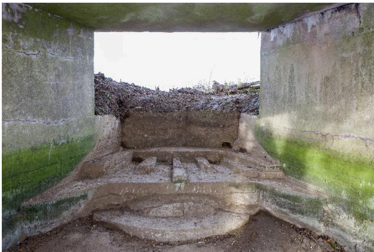
Vue intérieure de la chambre de tir, vers la sortie, avec au sol la plate-forme du canon
