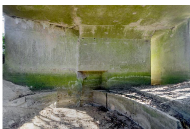
Depuis la cuve à canon de la chambre de tir, vers l'est et avant déblaiement. Phot. Jean-Marc Ramette IVR32_20175901051NUCA
