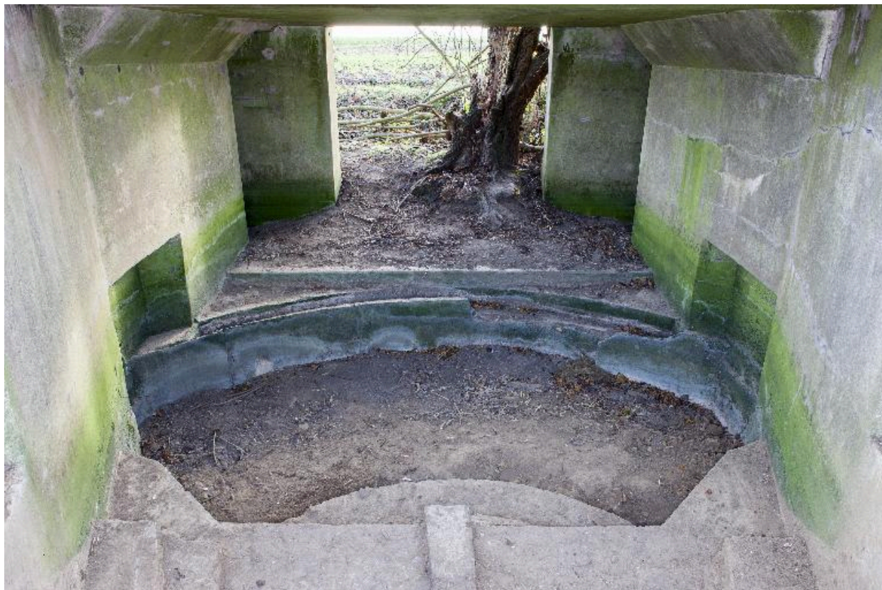
La chambre de tir, vers l'entrée avec, au sol, la plate-forme du canon
