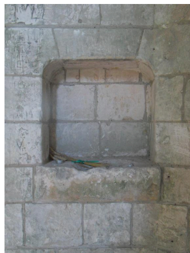
Crédence. Phot. Isabelle Barbedor IVR22_20108010164NUCA
