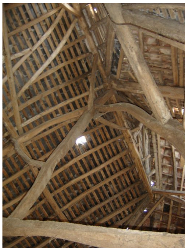
Autre vue détaillée de ferme. Phot. Inès Guérin IVR22_20058005841NUCA
