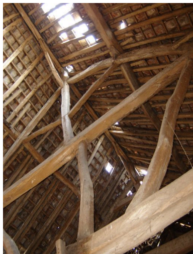
Vue détaillée d'une ferme de charpente d'une des deux granges. Phot. Inès Guérin IVR22_20058005840NUCA
