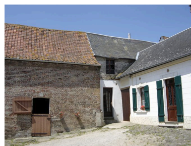
Vue de l'ancien emplacement de l'écurie. Phot. Inès Guérin IVR22_20058005831NUCA
