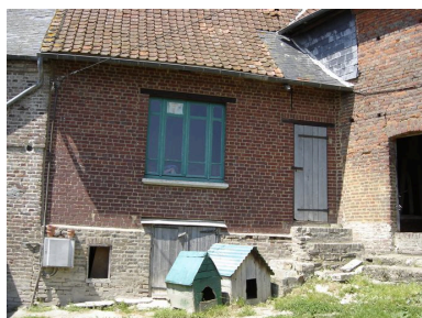
Vue extérieure de la cave située sous le second logement. Phot. Inès Guérin IVR22_20058005842NUCA
