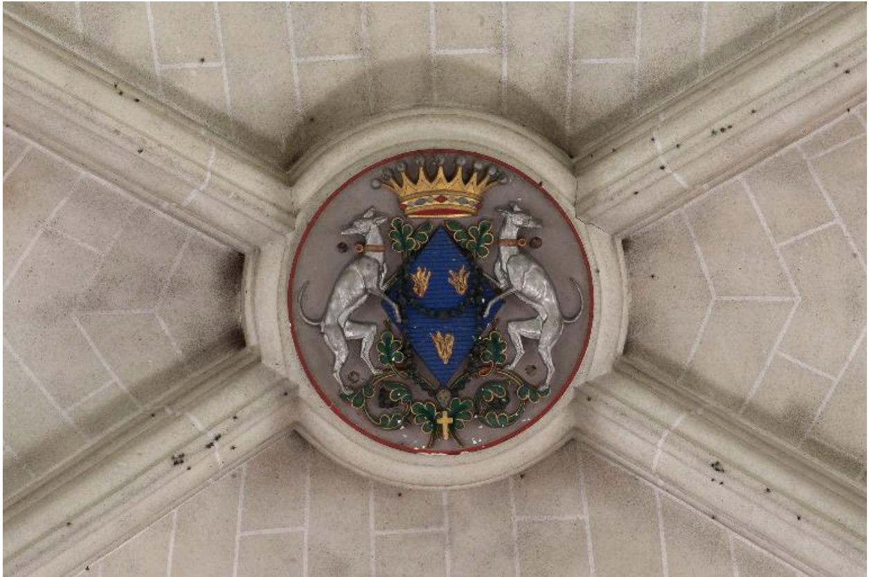
Clef de voûte de la croisée du transept sculptée et peinte aux armoiries de Charlotte de Brandt.
