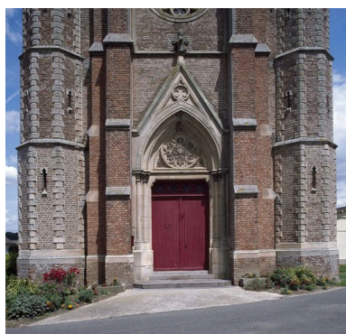
Vue partielle de la façade occidentale et du portail. Phot. Marie-Laure Monnehay-Vulliet IVR22_20098000210XA
