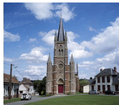
Vue générale de la façade occidentale sur la place. Phot. Marie-Laure Monnehay-Vulliet IVR22_20098000208XA
