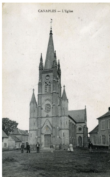
Façade occidentale, début du 20e siècle (coll. part.). Phot. Monnehay-Vulliet Marie-Laure IVR22_20098000406NUCA
