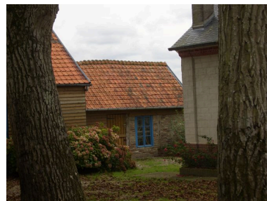
Vue d'une des dépendances à l'est du jardin. Phot. Inès Guérin IVR22_20068005547NUCA
