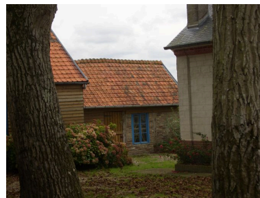
Vue d'une des dépendances à l'est du jardin. Phot. Inès Guérin IVR22_20068005547NUCA
