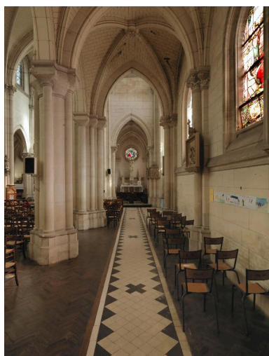
Vue intérieure du bas-côté sud. Phot. Thierry Lefébure IVR22_20148000527NUC2A
