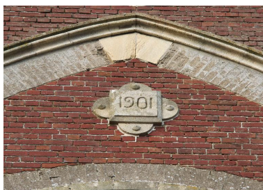
Date portée sur le mur extérieur du transept. Phot. Thierry Lefébure IVR22_20148000593NUC2A
