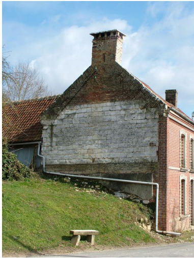
Vue du pignon extérieur du logis. Phot. Frédéric Fournis IVR22_20108001086NUCA
