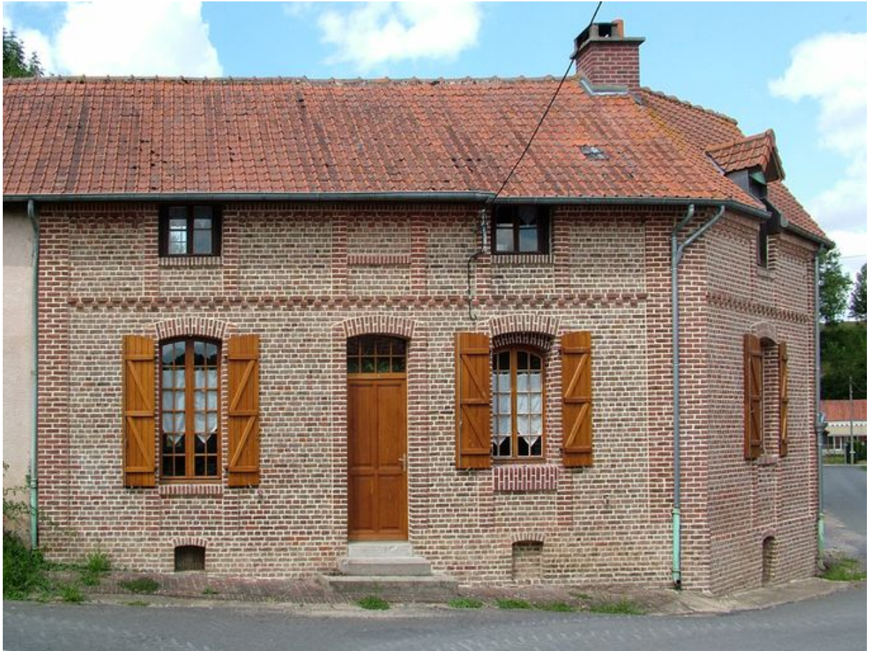
Ancien cabaret ou débit de boissons, 1 Grande-rue.
