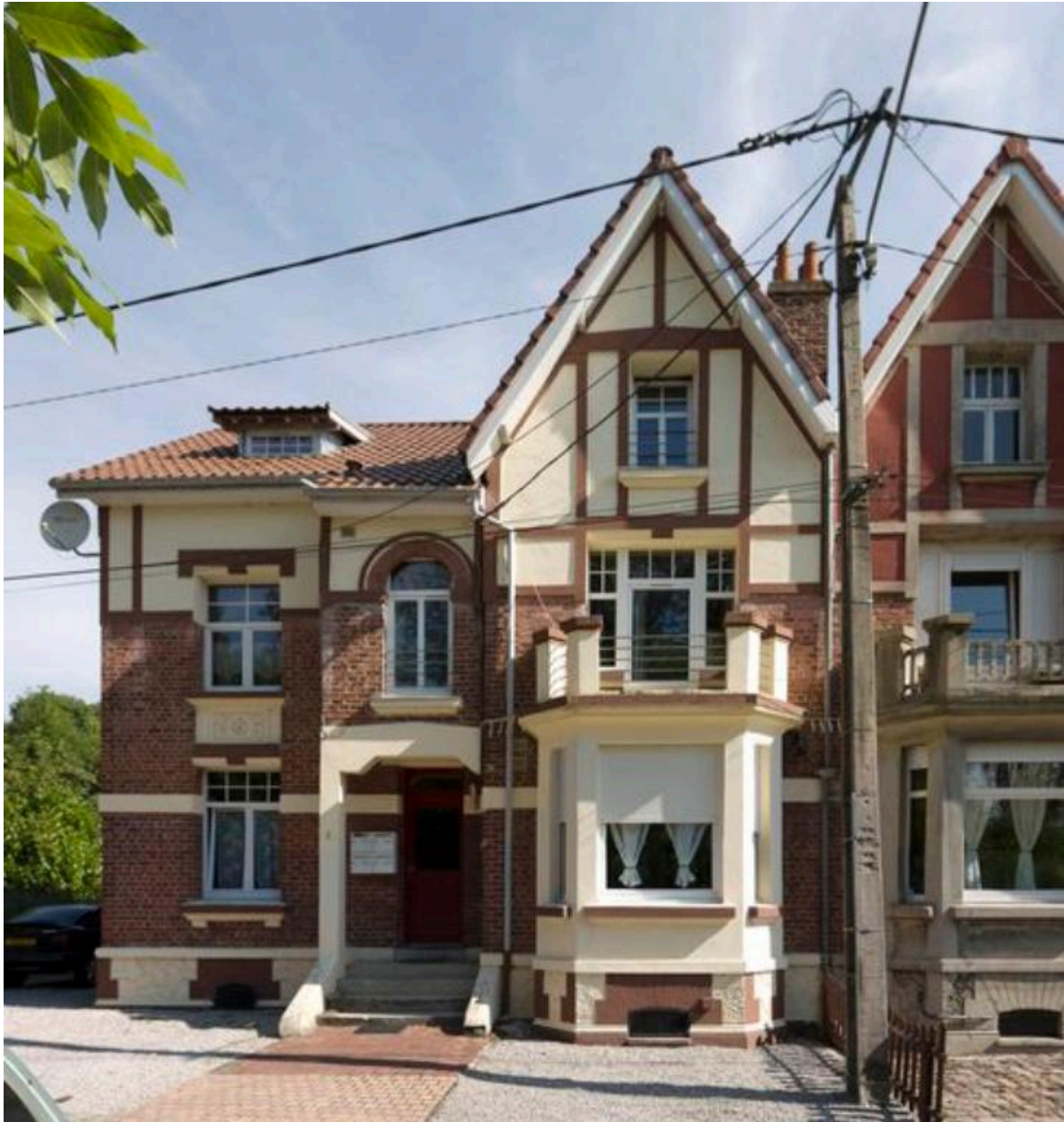
Vue générale d'un logement.
