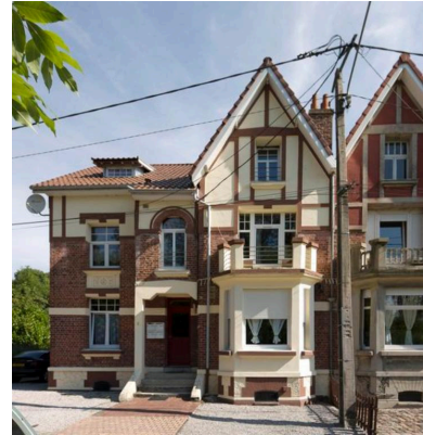
Vue générale d'un logement.
