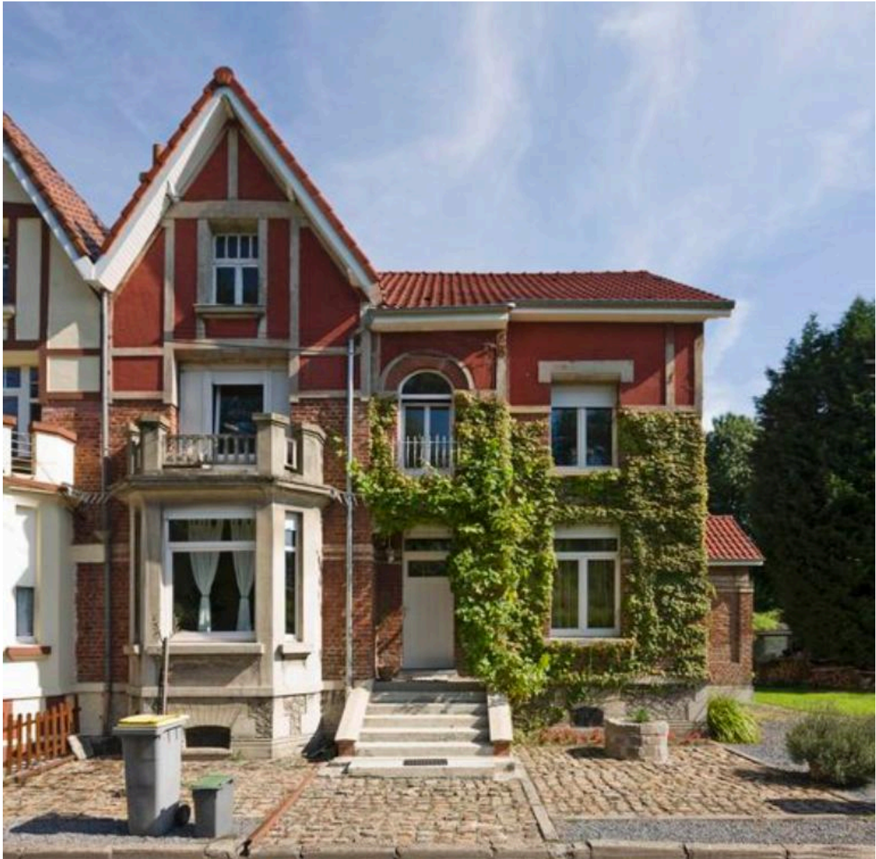
Vue générale d'un logement.
