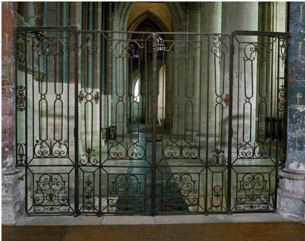
Vue partielle de la grille séparant le grand transept du collatéral sud du choeur.
