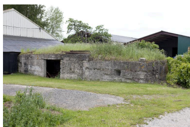
vue de trois-quarts vers le sud-ouest Phot. Jean-Marc Ramette IVR31_20145905234NUCA
