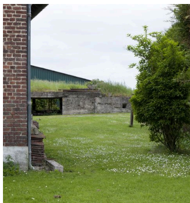
Vue de l'édifice depuis la rue Phot. Jean-Marc Ramette IVR31_20145905232NUCA
