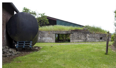
Vue de l'édifice vers le nord-est. Au centre l'accès à la chambre de tir, à droite la soute à munitions Phot. Jean-Marc Ramette IVR31_20145905233NUCA
