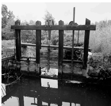
Vannes de décharge. Phot. Patrick Glotain IVR22_19936000641X
