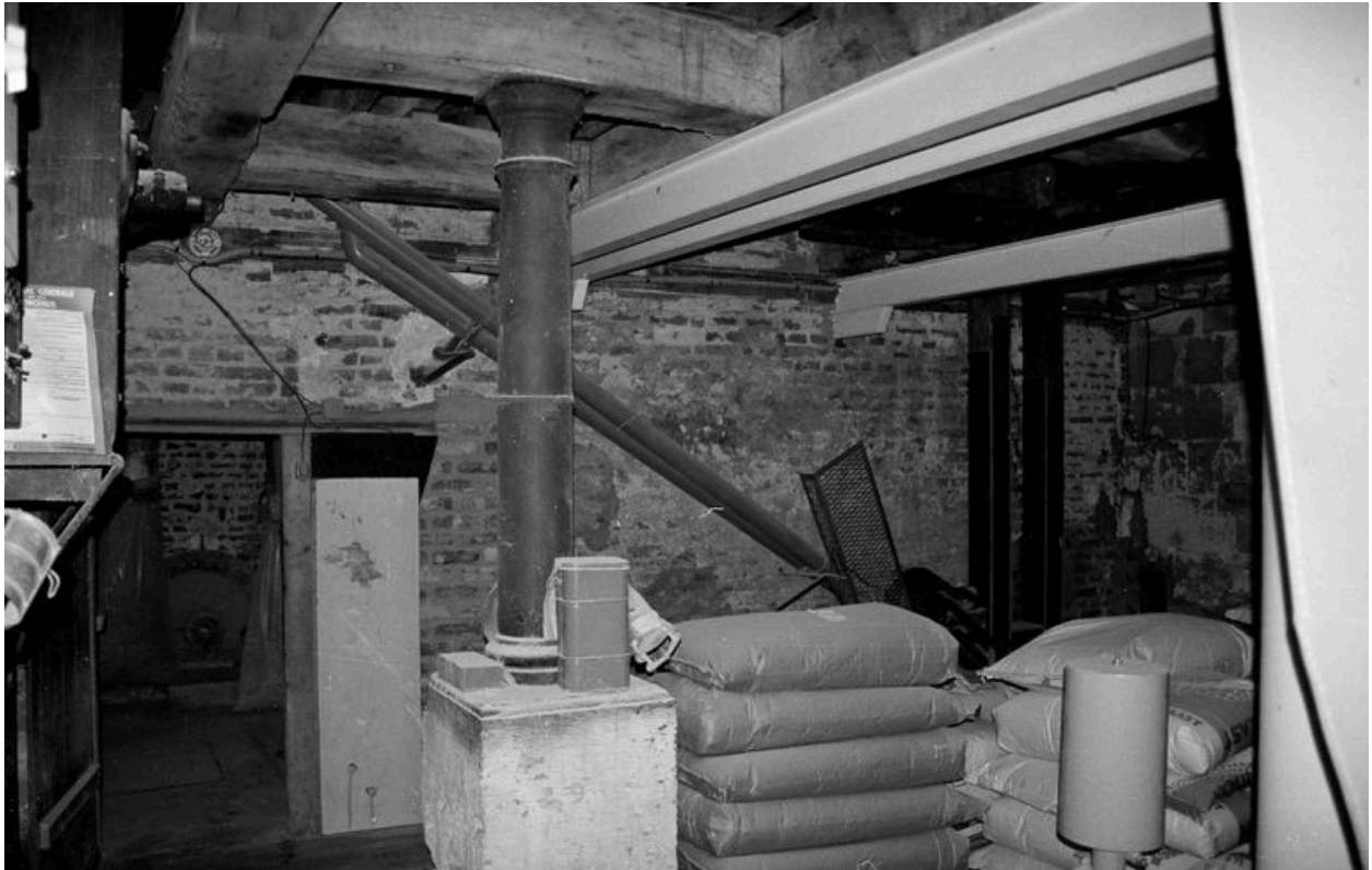
Rez-de-chaussée de l'ancien moulin, occupé autrefois par le mécanisme de transmission de la force hydraulique.
