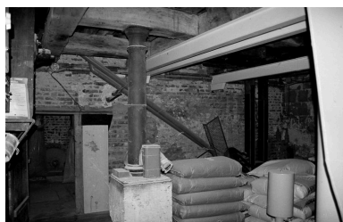
Rez-de-chaussée de l'ancien moulin, occupé autrefois par le mécanisme de transmission de la force hydraulique. Phot. Bertrand Fournier IVR22_20006000035Z
