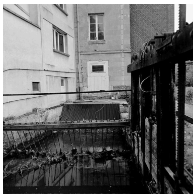
Vannes de décharge. Phot. Patrick Glotain IVR22_19936000639X
