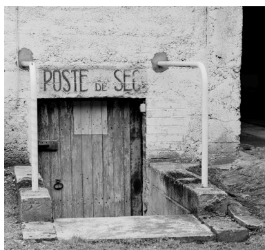
Entrée du poste de secours. Phot. Patrick Glotain IVR22_19936000644X
