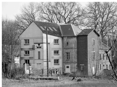
Vue générale, flanc nord ouest. Phot. Benoît Dufournier IVR22_19936000029Z
