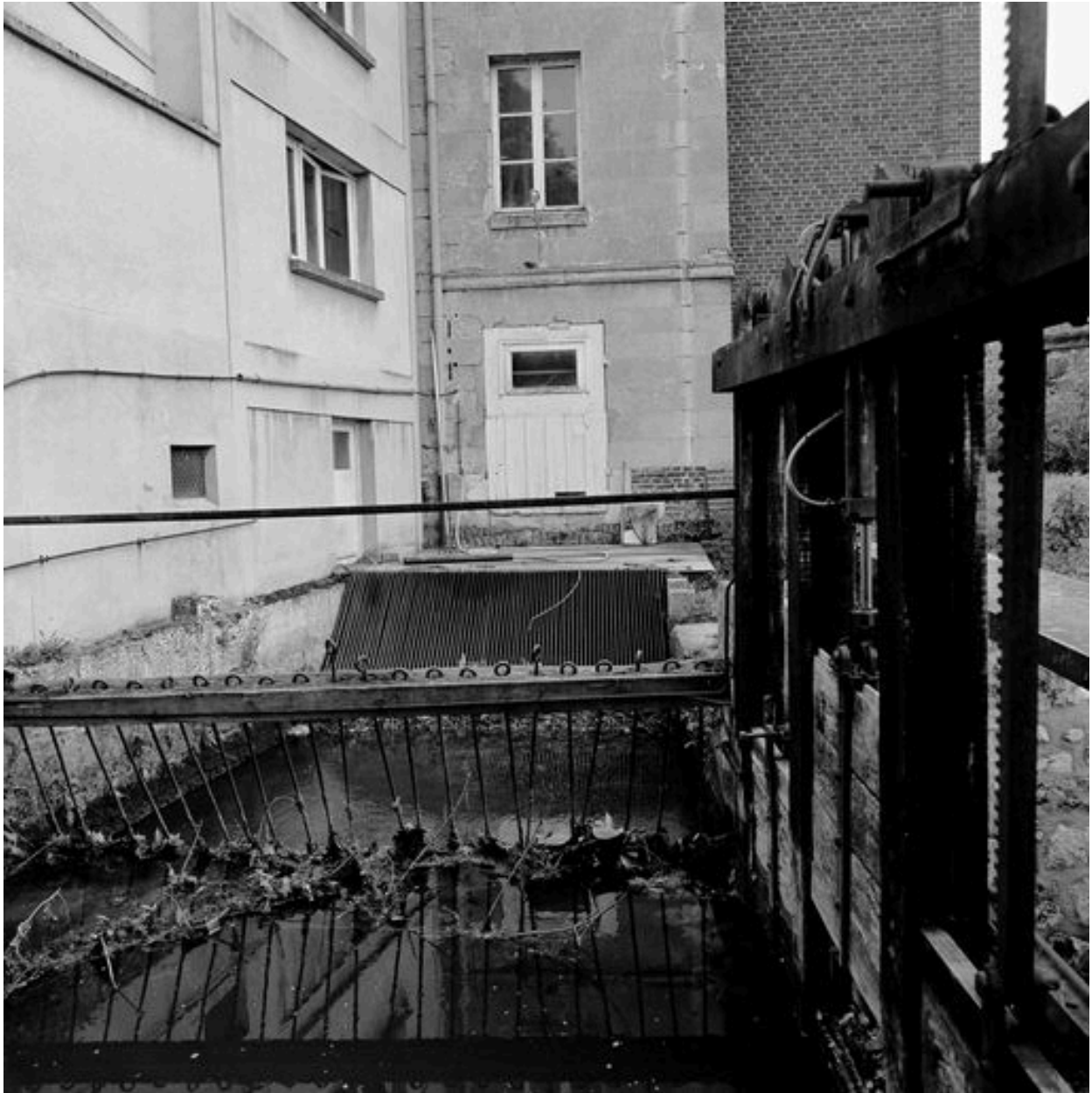
Vannes de décharge.
