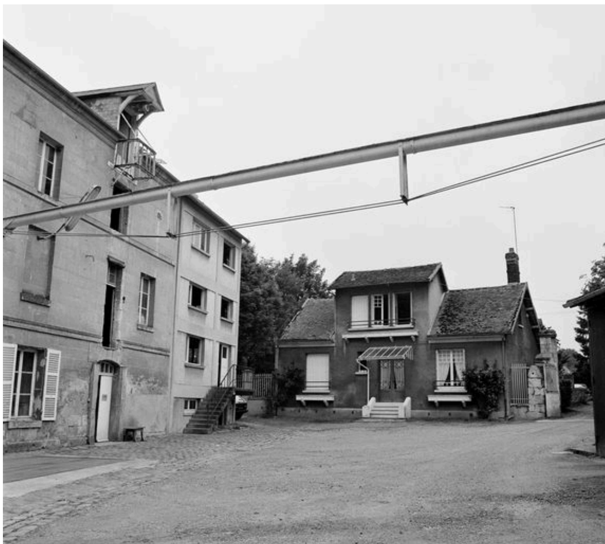
Atelier de fabrication et logement patronal.
