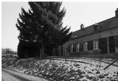
Vue générale. Logis et étable. Phot. Thierry Lefébure IVR22_19960200968X
