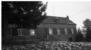
Vue du logis. Phot. Thierry Lefébure IVR22_19960200970X
