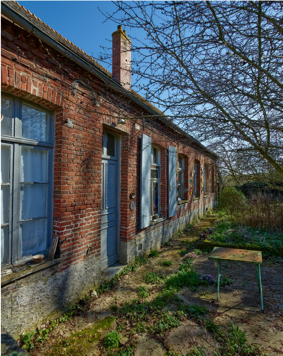
Vue de l'élévation ouest.
