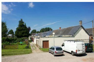
Vue de la desserte des jardins de la cité ouvrière. Phot. Thierry Lefébure IVR22_20148000431NUC2A
