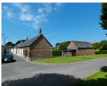
Vue de la cité Hurtel, depuis la rue Achille-Pruvost. Phot. Thierry Lefébure IVR22_20148000430NUC2A
