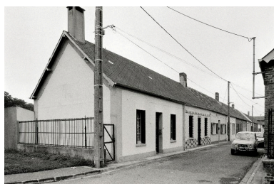
Vue de la cité Hurtel, en 1991. Phot. Benoît Dufournier IVR22_19918000130Z
