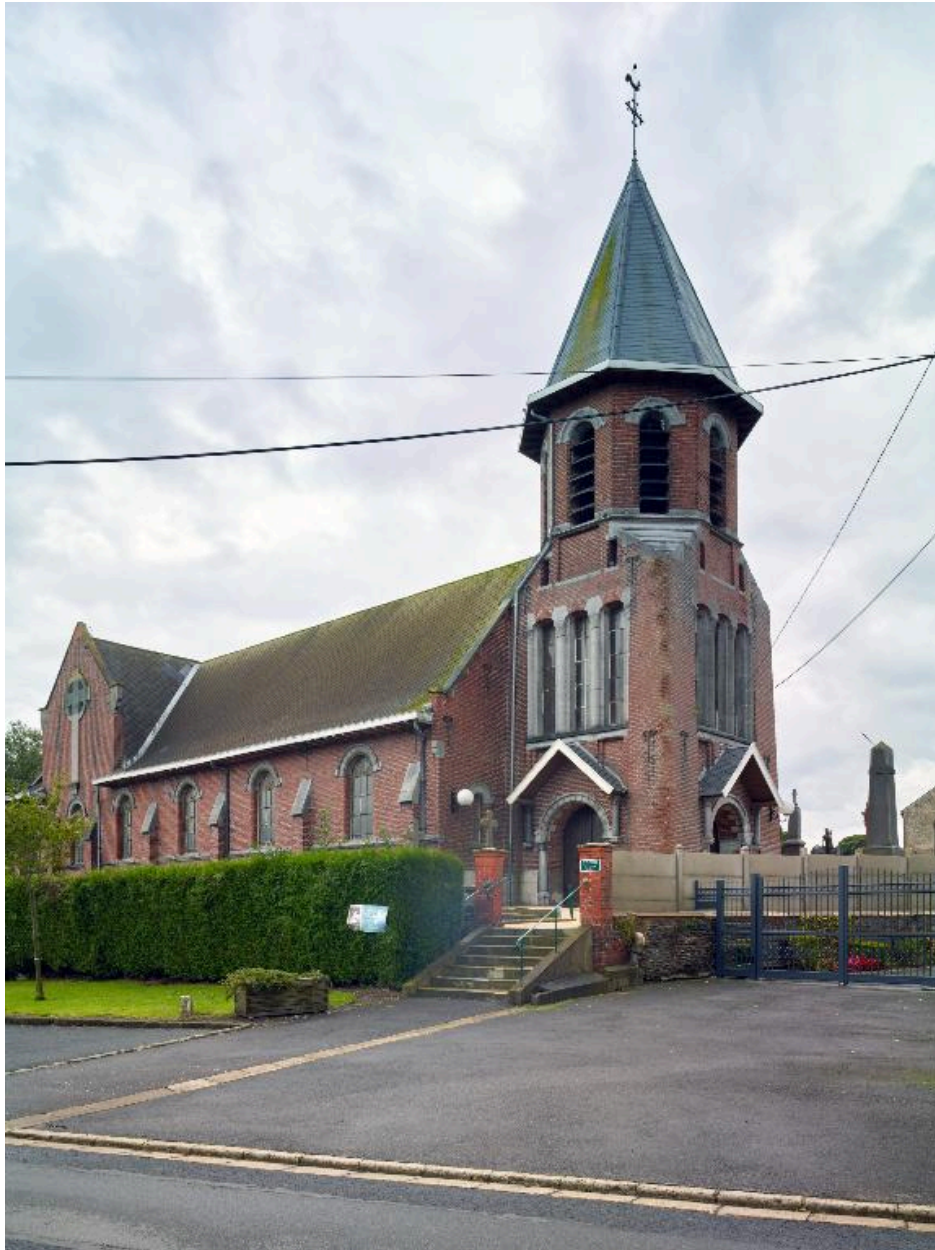
Vue générale de trois quarts, élévation nord.
