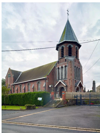
Vue générale de trois quarts, élévation nord.
