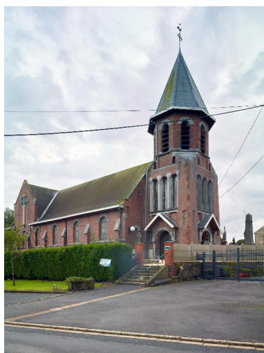
Vue générale de trois quarts, élévation nord.
