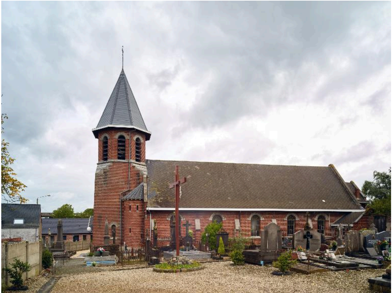
Vue générale de trois quarts, élévation sud.
