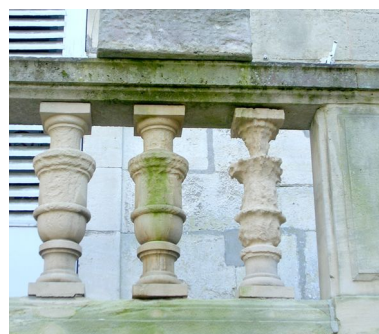
Détail des balustres en pierre de l'escalier.
