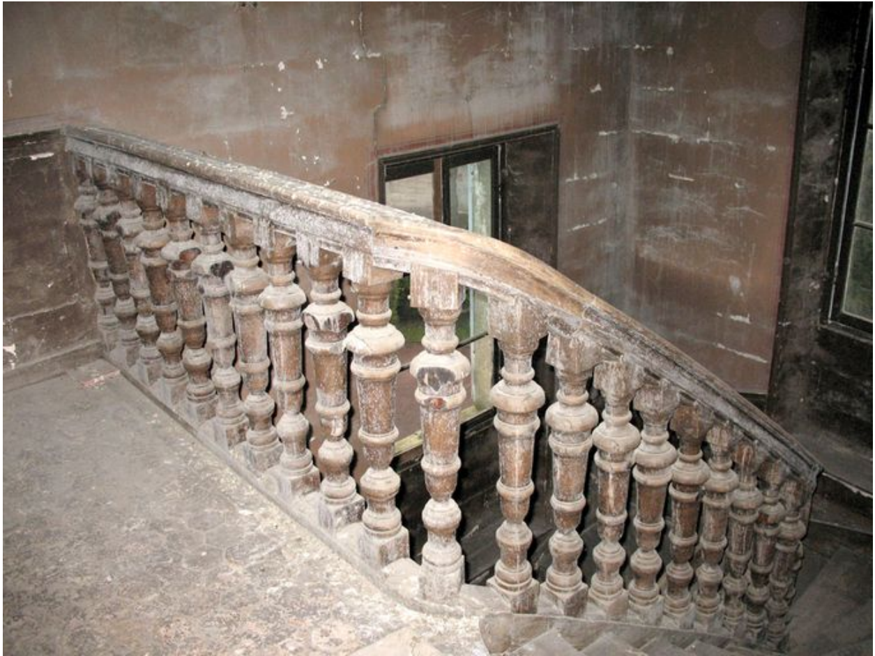
Balustrade et escalier en bois desservant les étages du château.
