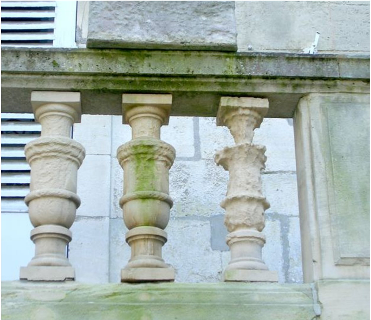
Détail des balustres en pierre de l'escalier.
