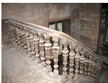
Balustrade et escalier en bois desservant les étages du château.
