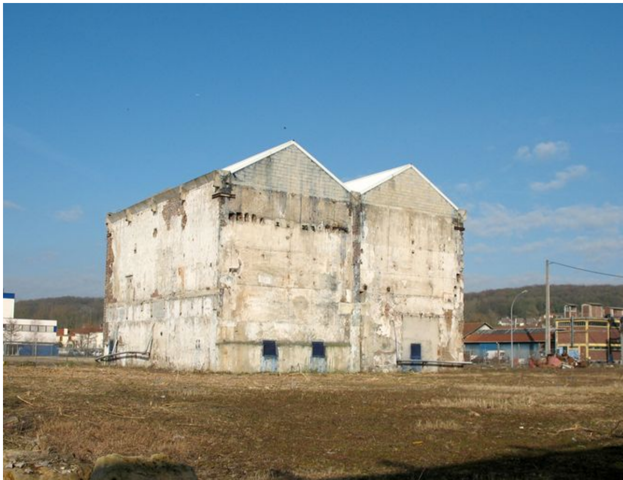
Bâtiment n°1 (atelier de colorants) sur la plate forme chimique de Villers Saint Paul.
