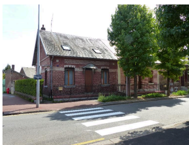
Maisons, 3-5 et 7 avenue d'Estournelles-de-Constant. Phot. Isabelle Barbedor IVR32_20170205281NUCA
