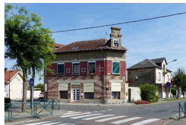
Ancien café, rue Raymond-Poincaré. Phot. Isabelle Barbedor IVR32_20170205289NUCA
