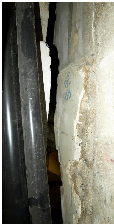
Vestige d'un carreau de faïence émaillé d'un motif de fleurs bleues, qui ornait la piscine à l'origine (1926).
