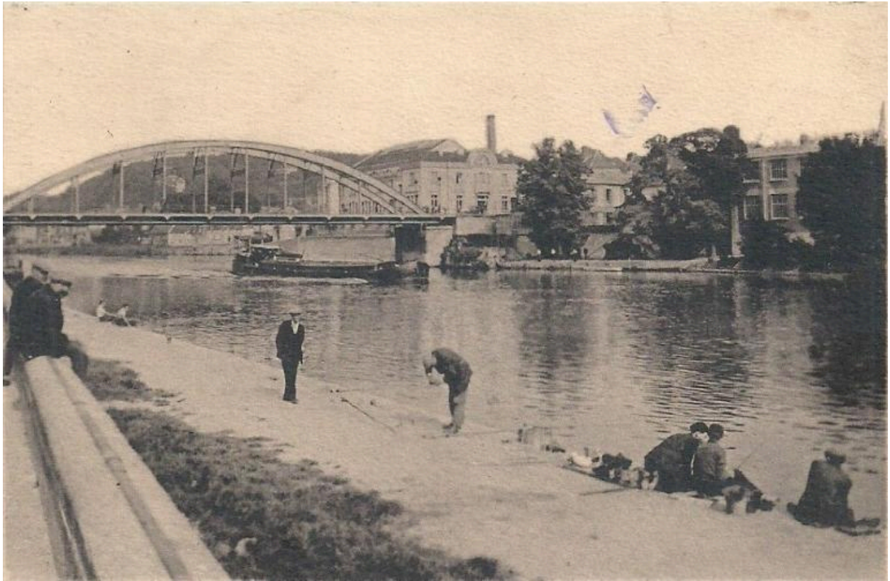
L'Oise et le pont métallique, avec en arrière-plan, la piscine de Creil. Carte postale, vers 1930 (coll. part.).
