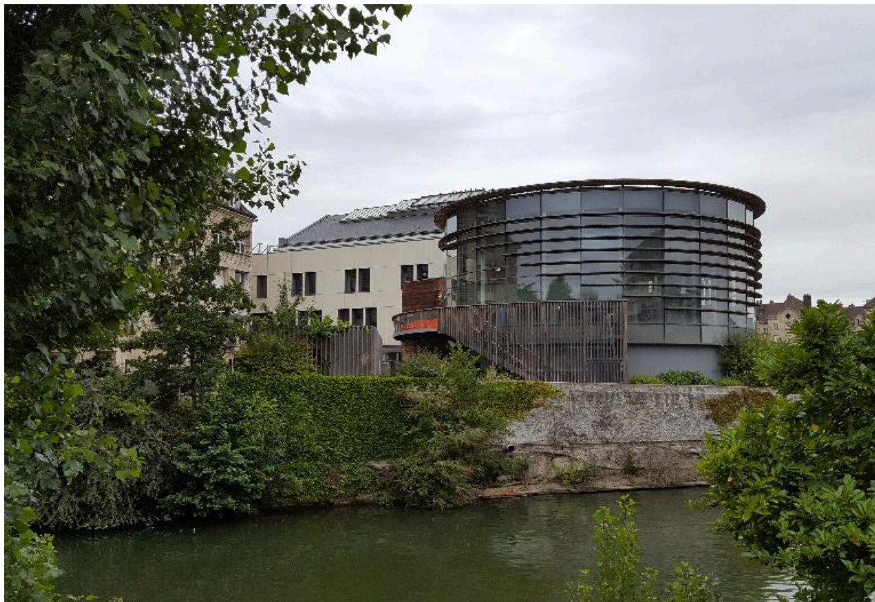
Vue de la façade sud, avec l'extension abritant les nouveaux bassins ludiques.
