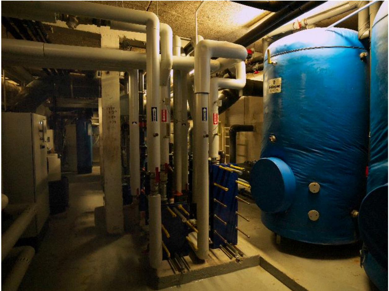
Vue générale de la machinerie en sous-sol ; à droite les ballons d'eau chaude.
