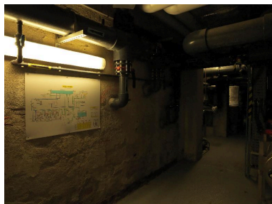
Entrée des locaux techniques en sous-sol.
