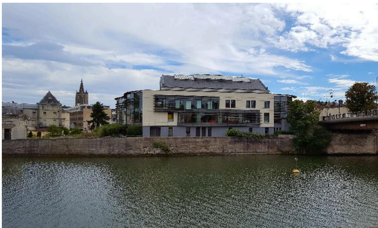
Vue générale de la façade nord, côté Oise.
