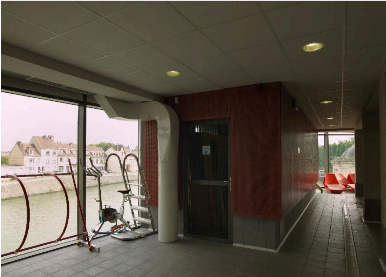
Ancien emplacement des douches (aujourd'hui local de rangement de matériel).
