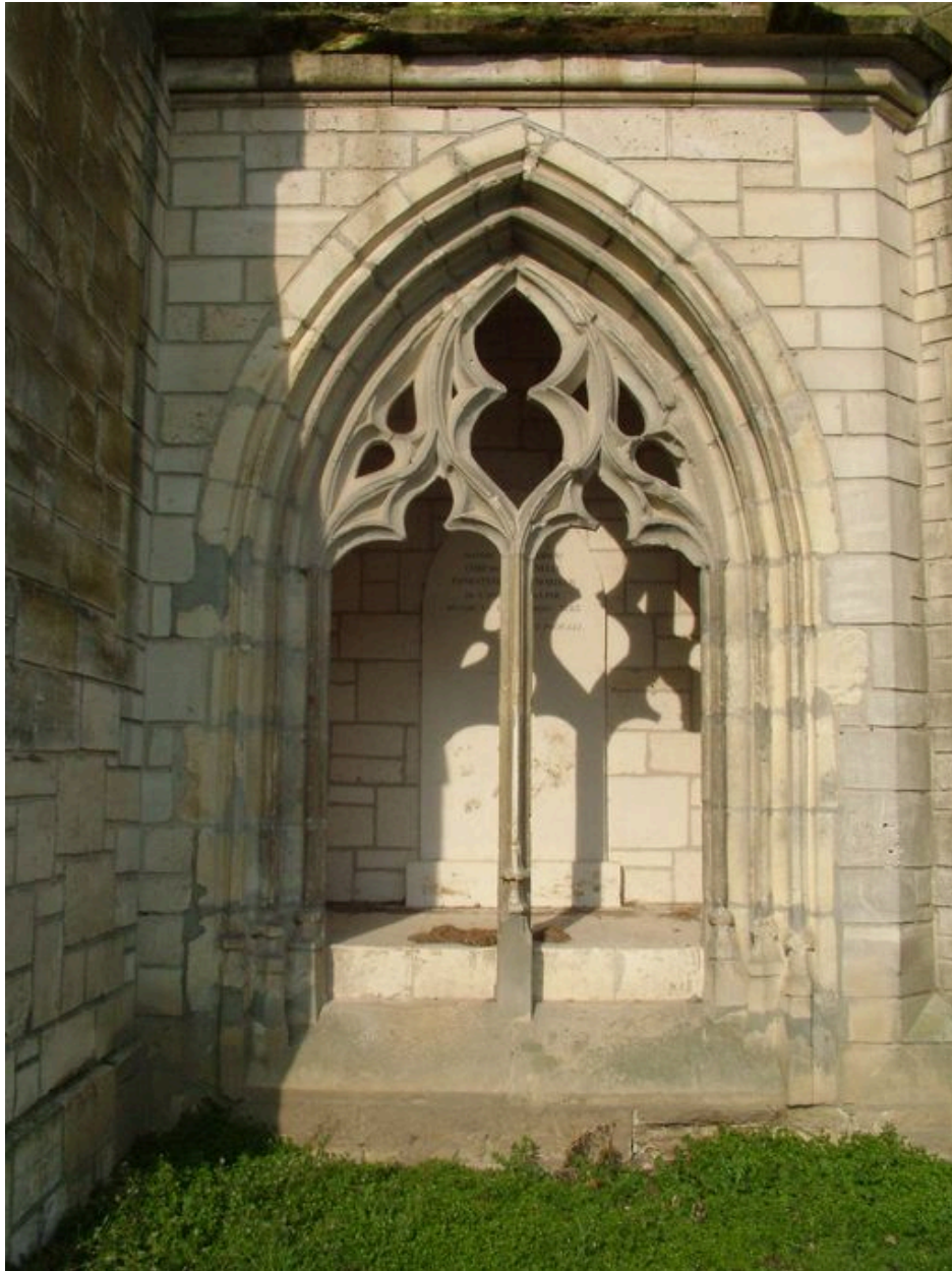
Vue du fenestrage ancien intégré dans la nouvelle construction.
