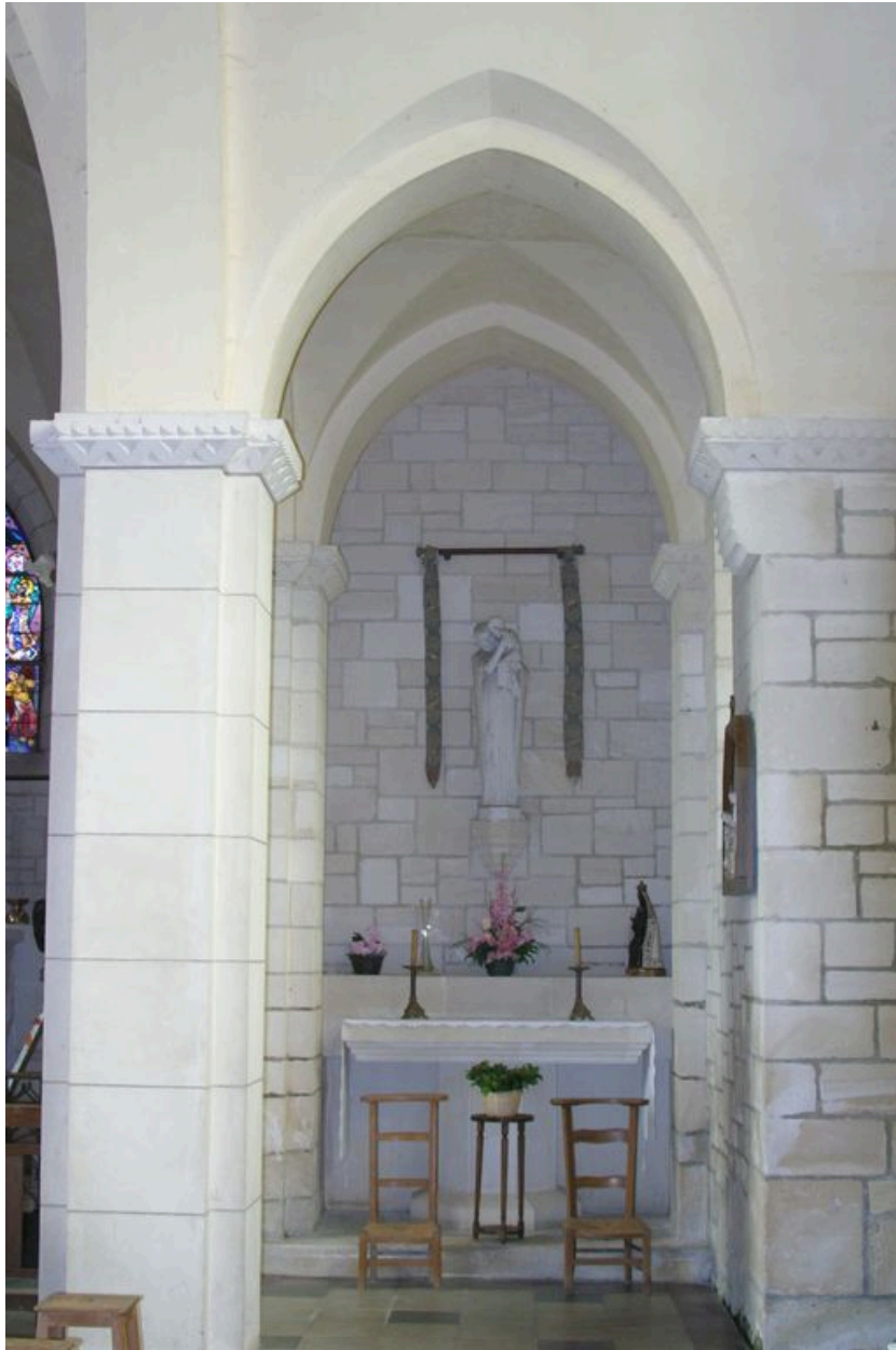
Vue de la chapelle secondaire.
