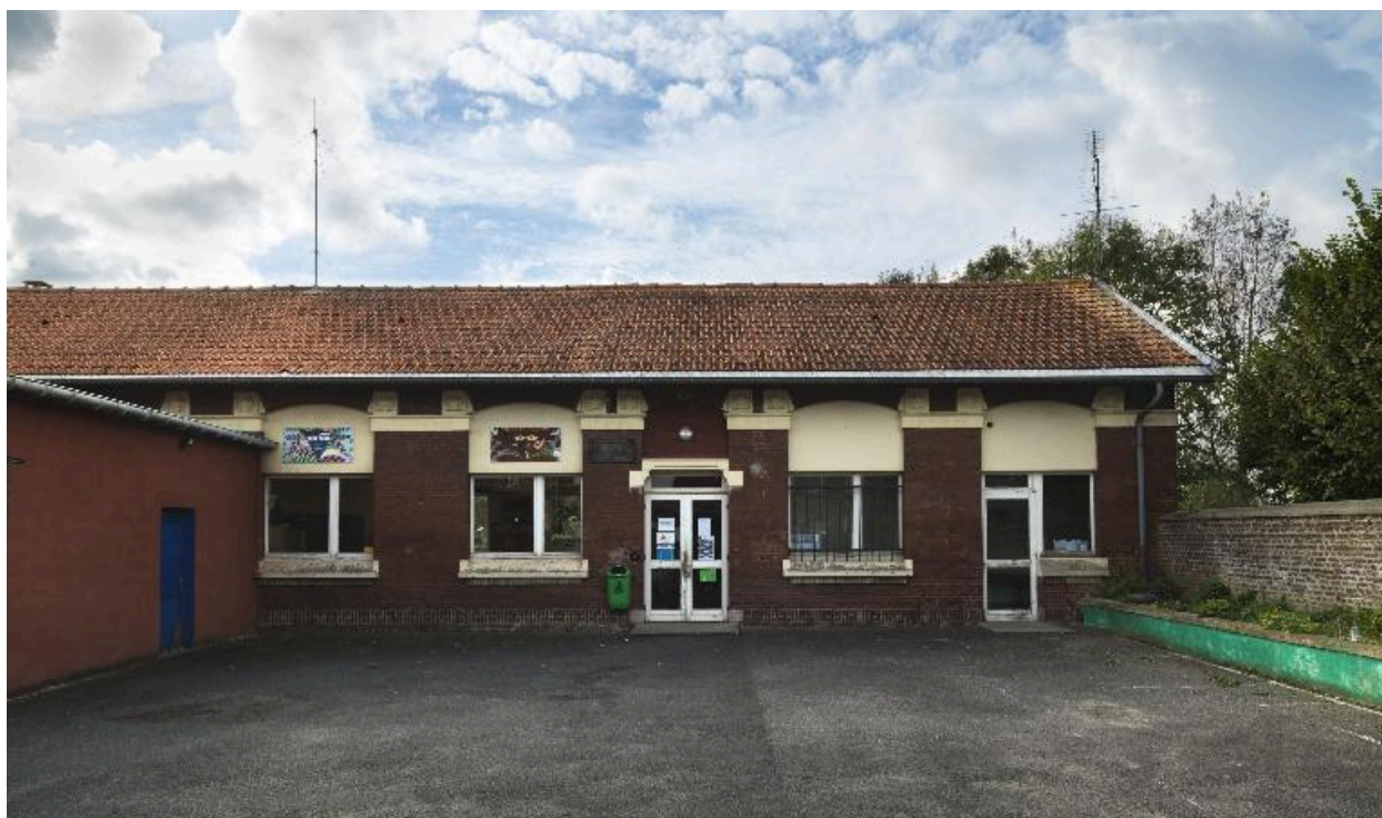
Vue des anciennes salles de classe situées au fond de la cour.
