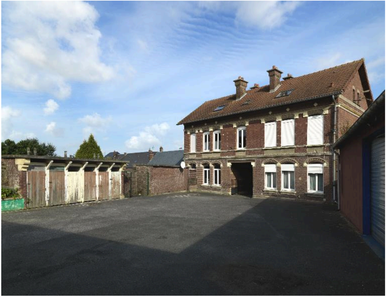
Vue de la façade postérieure des logements et des cabinets d'aisance.
