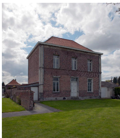
Elévation postérieure de la mairie, façade en brique non enduite et pilastres ioniques aux angles. Phot. Pierre Thibaut IVR31_20125901629NUCA
