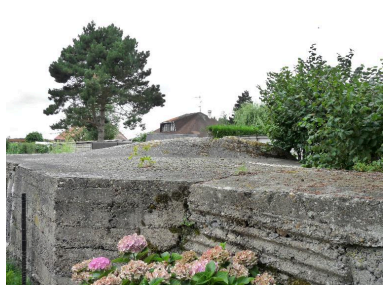
Elévation sud, salle ouest Phot. Eddy Stein IVR32_20185900088NUCA
