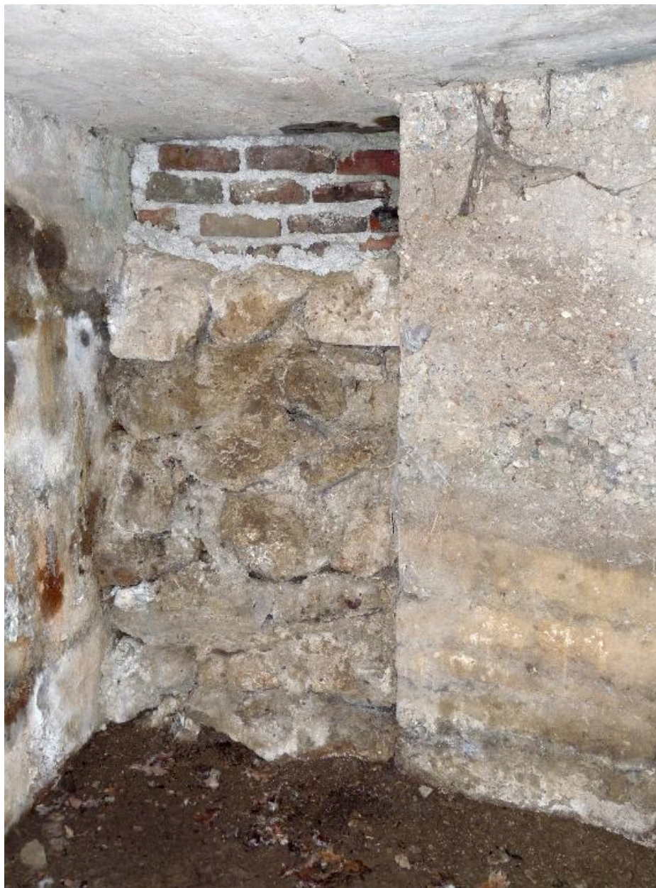
Extrémité ouest du couloir
