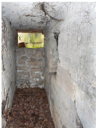
Extrémité est du couloir. Phot. Eddy Stein IVR32_20185900091NUCA
