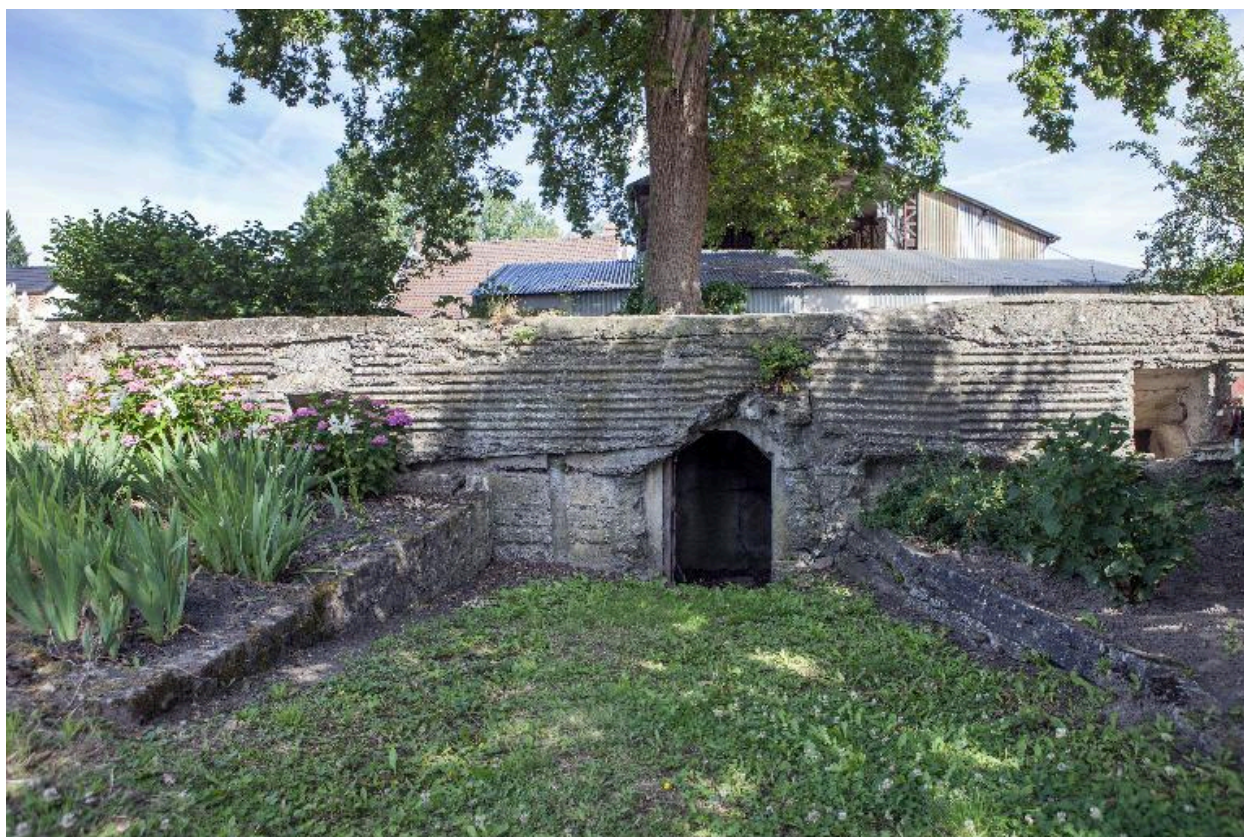
Elévation sud : Entrée encadrée de deux baies obliques (resseres à mitrailleuses ?)
