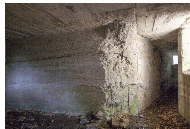
Vue intérieure vers l'est. A gauche, une des deux salles de l'édifice. A droite le couloir qui s'infléchit vers le sud. Phot. Pierre Thibaut IVR31_20155901326NUCA
