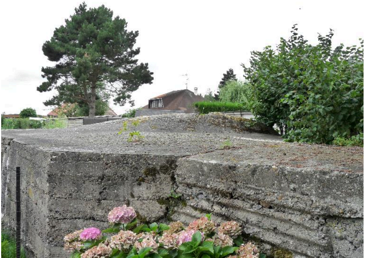
Elévation sud, salle ouest
