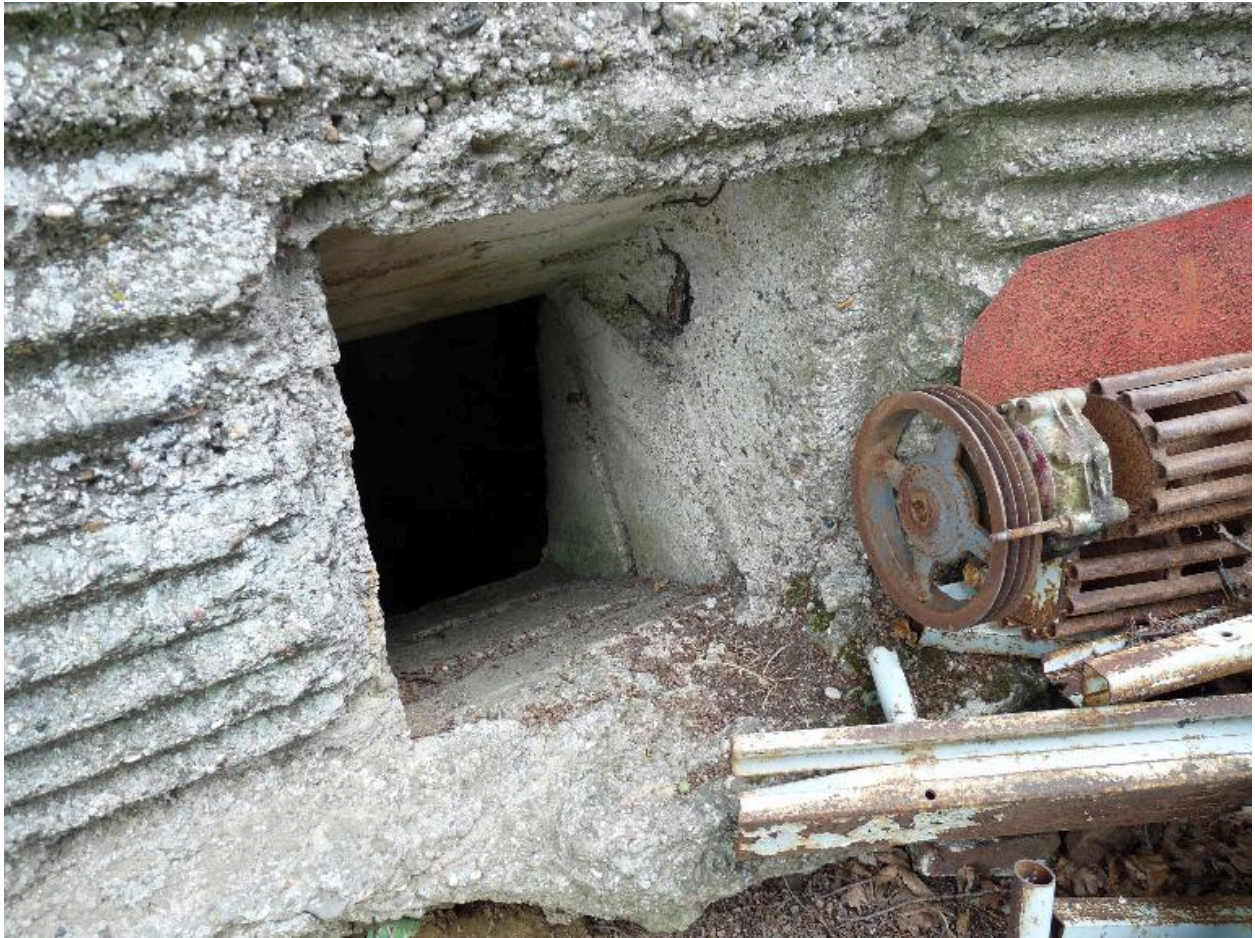
Elévaton sud. Ressesse à mitrailleuse ?
