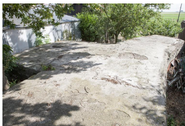
Couvrement, l'est Phot. Pierre Thibaut IVR31_20155901322NUCA
