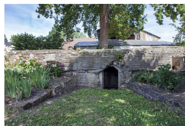
Elévation sud : Entrée encadrée de deux baies obliques (resseres à mitrailleuses ?) Phot. Pierre Thibaut IVR31_20155901319NUCA
