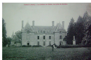
Vue postérieure de l'ancien château (coll. part). Phot. Inès Guérin IVR22_20030203284NUCAB
