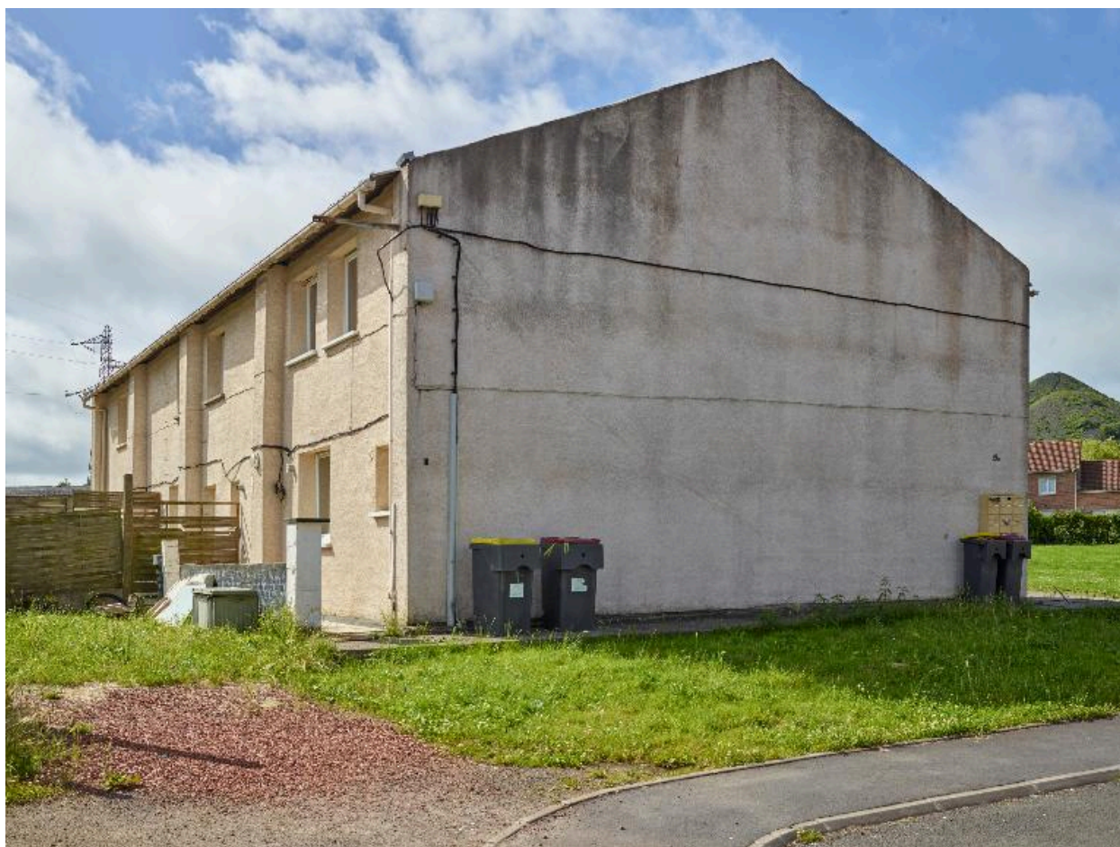
Elévation générale ; chapelle transformée en logements.
