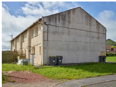
Elévation générale ; chapelle transformée en logements.
