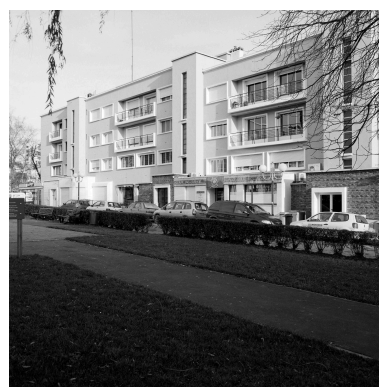
Vue générale de l'élévation postérieure de l'immeuble Les Arcades, construit par l'architecte Jean Badovici. Phot. Thierry Petitberghien IVR31_20025902921X
