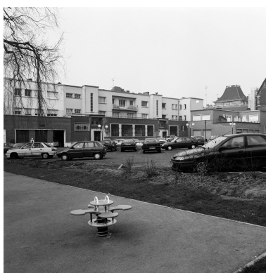
Élévation postérieure de la banque Crédit du Nord, rue Lazare Carnot. Phot. Thierry Petitberghien IVR31_20035900298X
