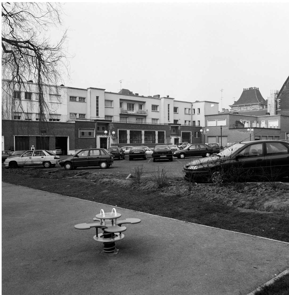
Élévation postérieure de la banque Crédit du Nord, rue Lazare Carnot.
