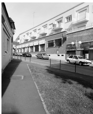
Élévation antérieure de la banque Crédit du Nord, rue Lazare Carnot. Phot. Thierry Petitberghien IVR31_20025902324X
